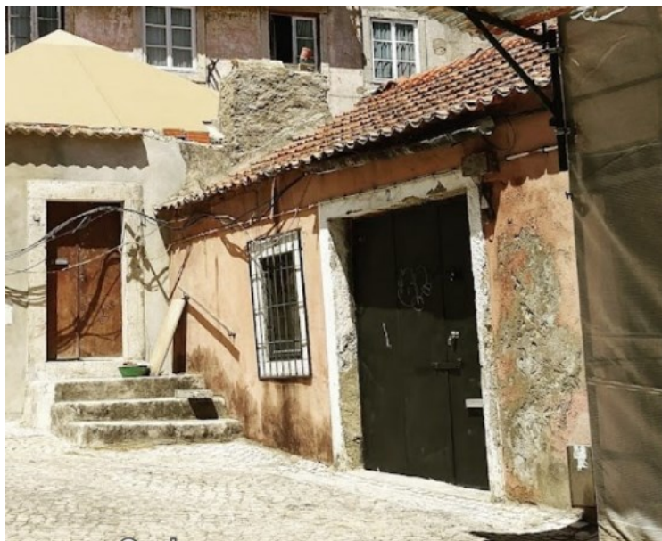
Figura 3.1 – Fotografia da edificação a reabilitar
