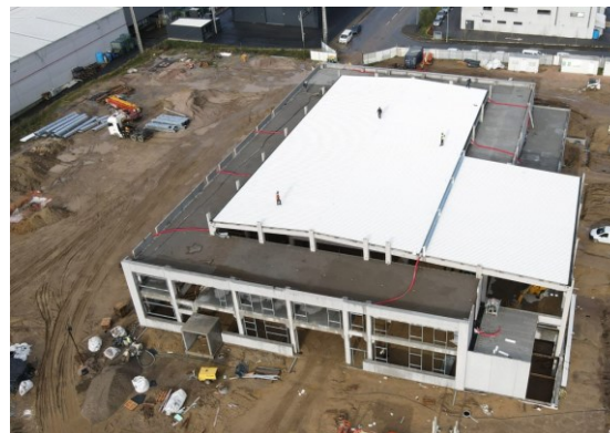
b) Construção de edifício do setor farmacêutico em lote industrial (Arquitetura e Especialidades)
