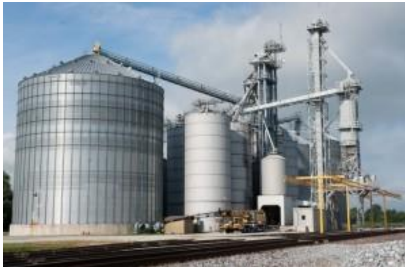
Figura 7 - Silos de Armazenamento - Estrutura de Armazenamento [8]
