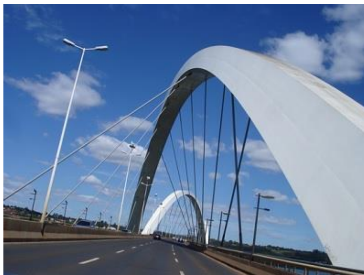
Figura 6 - Ponte Juscelino Kubitschek - Estrutura Tensionada [8]
