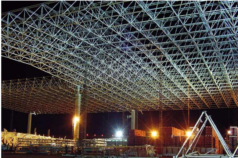
Figura 5 - Estrutura Espacial em Tubos de Aço [7]
