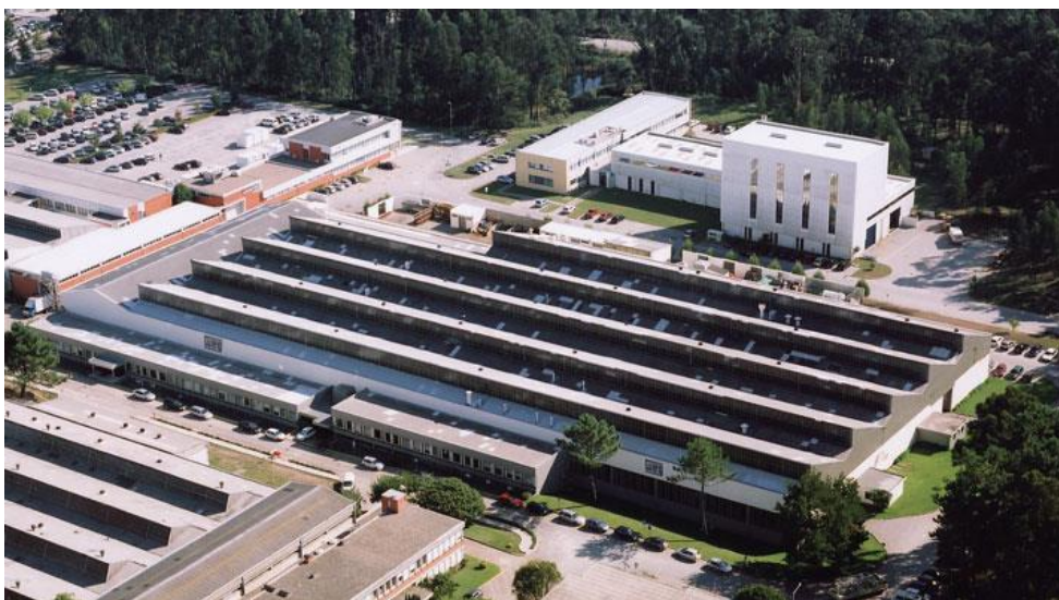
Figura 9 WEGeuro – Indústria Eléctrica S.A. da Maia, Portugal [7]
