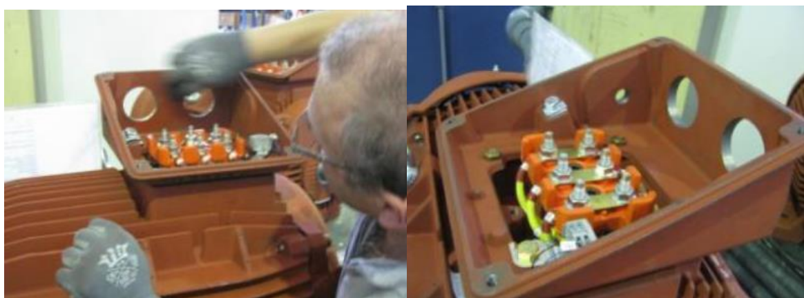
Figura 42 Limpeza do interior da caixa de ligação
