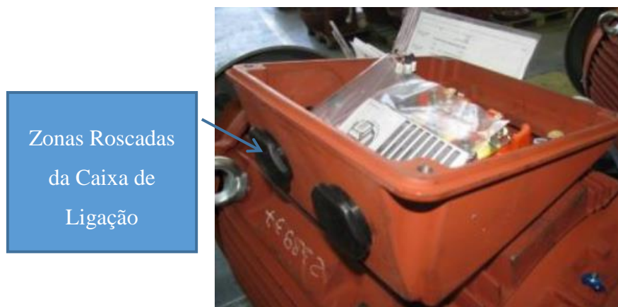
Figura 44 Obturação dos aterramentos e das furações
