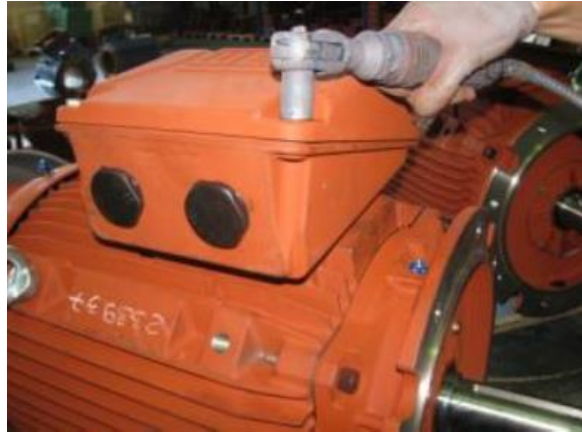
Figura 45 Fixação da caixa de ligação
