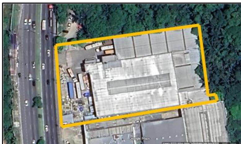
Figura 6 - Vista Aérea da Unidade Industrial Fonte: Google Maps
