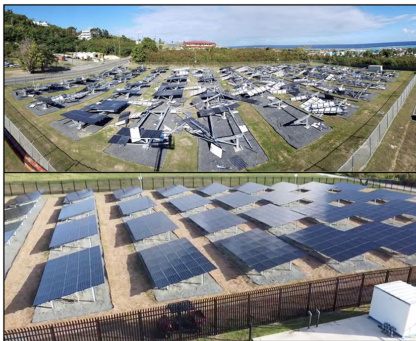
Figura 2.1: Danos causados por tempestades em St. Croix após o furacão Maria (em cima) e após o furacão Fiona (em baixo). Fotografias de Gerald Robinson, Lawrence Berkeley National Laboratory (em cima) e Schneider Electric (em baixo).
