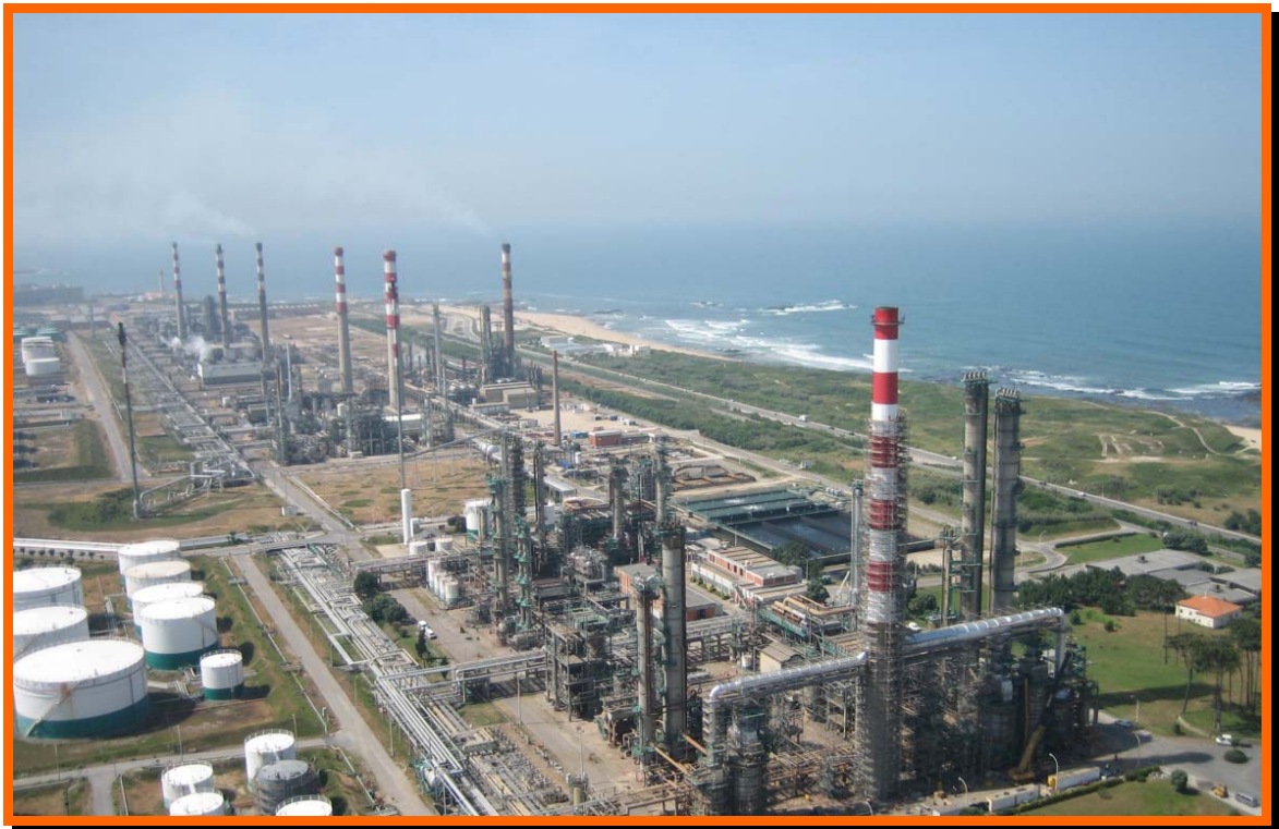
Figura 1 – Vista aérea da Fábrica de Aromáticos (FAR)
