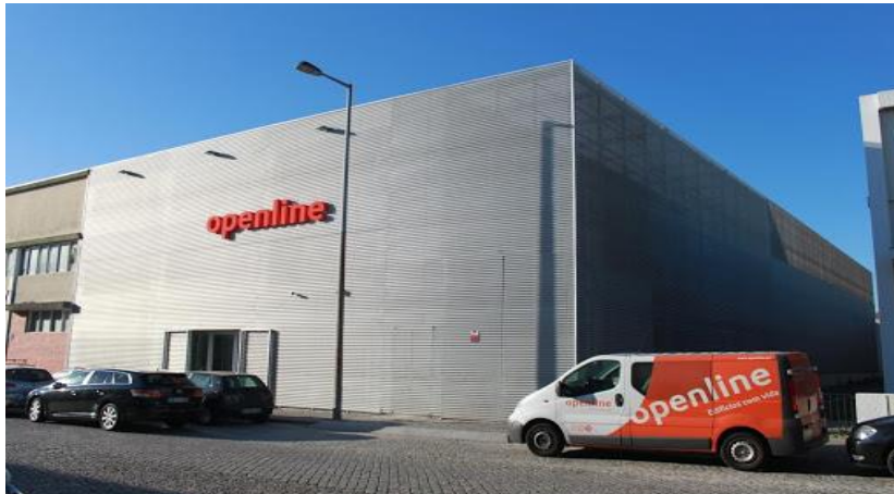
Figura 6 - Sede OPENLINE e armazém.
