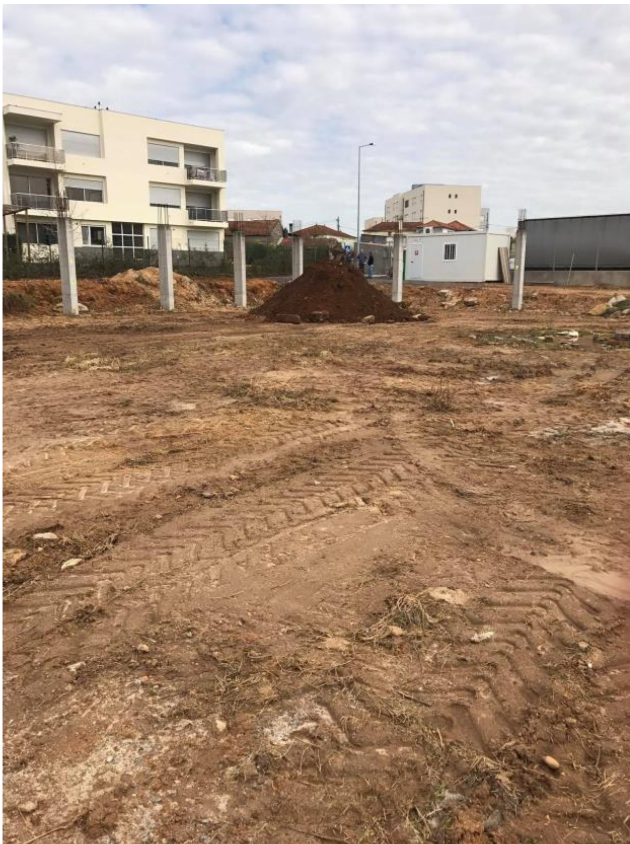
Figura 4.3 – Local de obra
