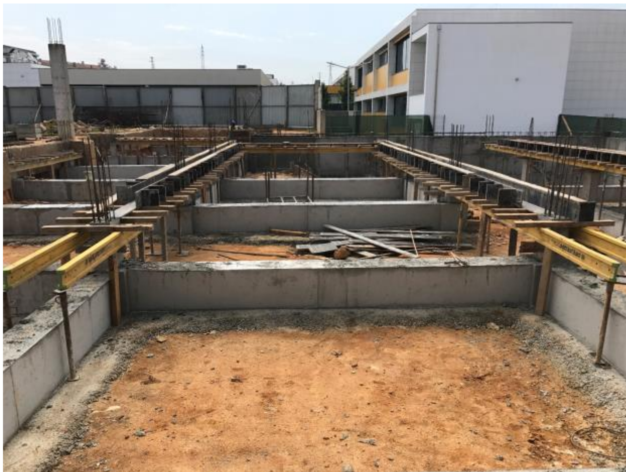
Figura 4.10 – Vigas construídas na zona de balneários
