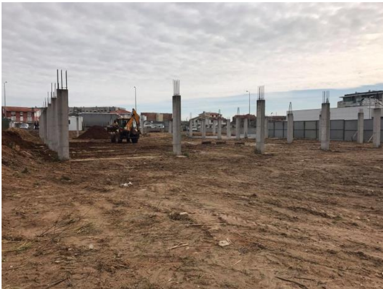
Figura 4.1 – Trabalhos de limpeza do terreno
