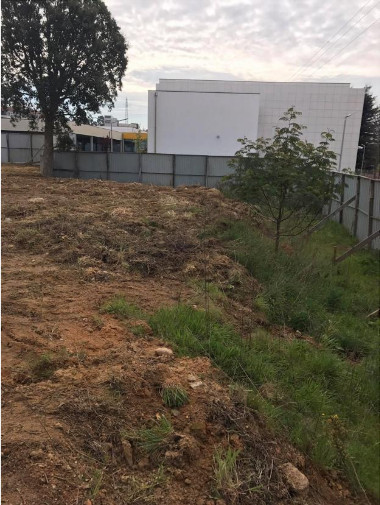
Figura 4.2 – Zona de construção dos balneários
