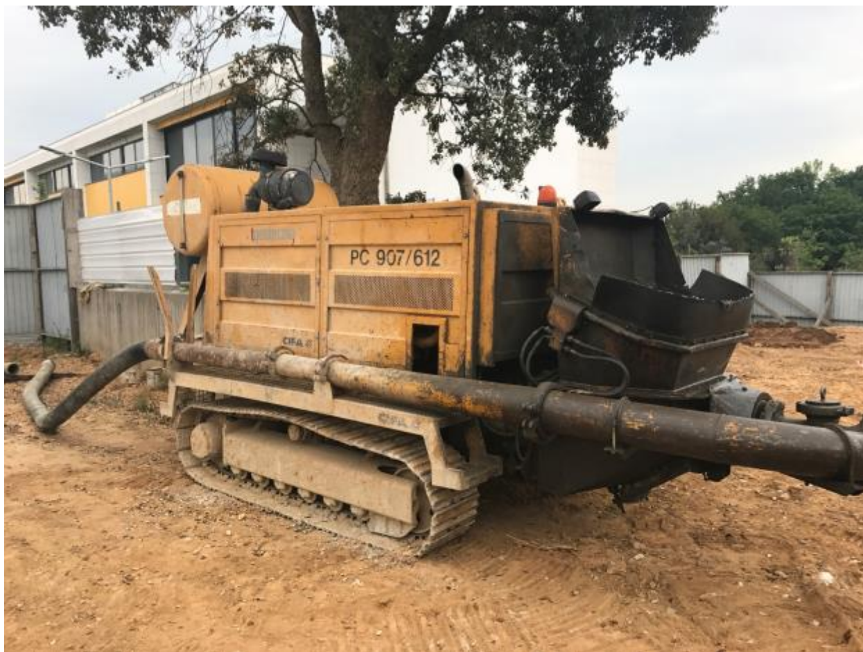
Figura 4.6 – Máquina utilizada para bombear betão para o equipamento de perfuração do solo
