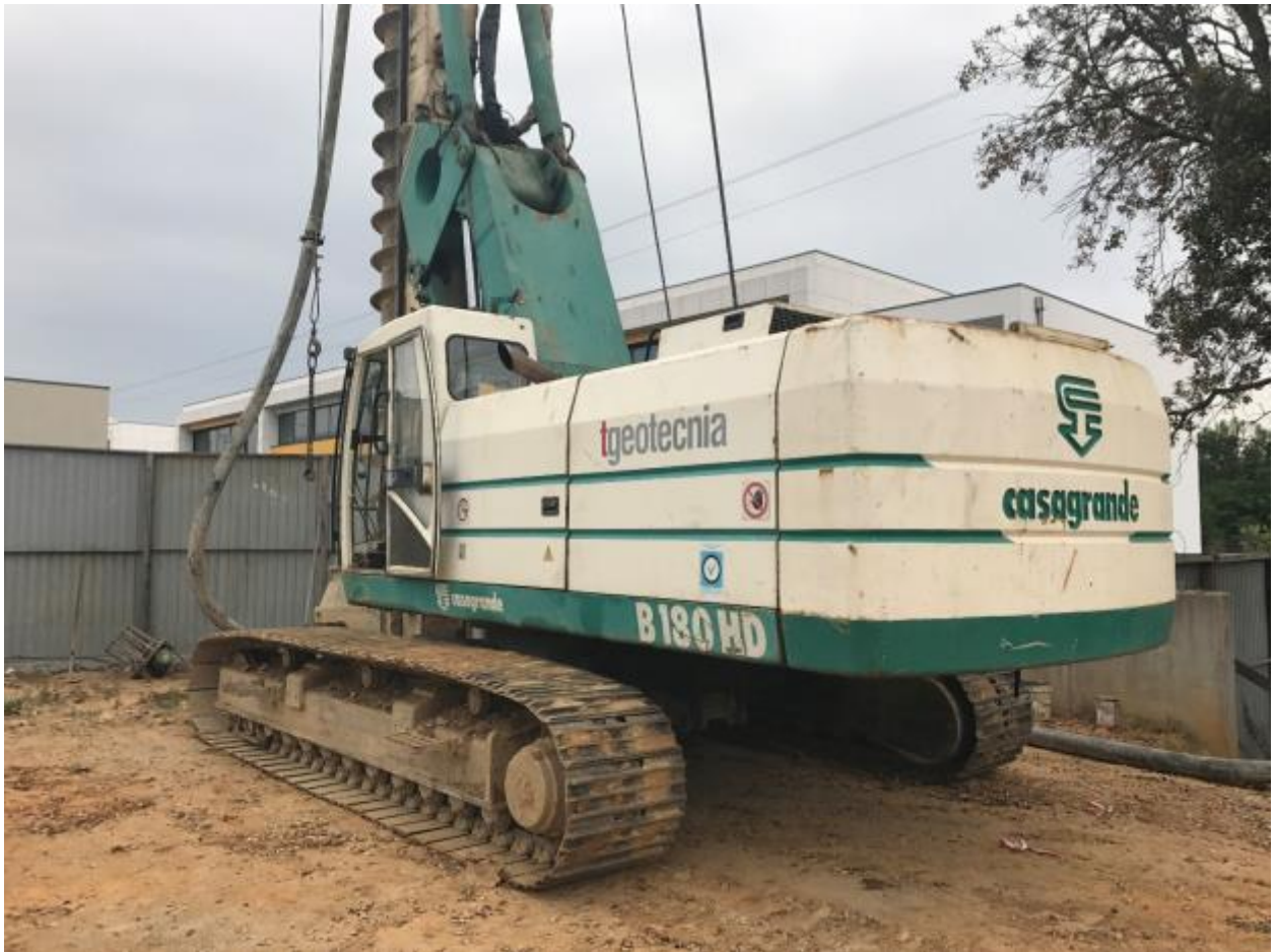
Figura 4.7 – Equipamento utilizado para perfuração e colocação das estacas
