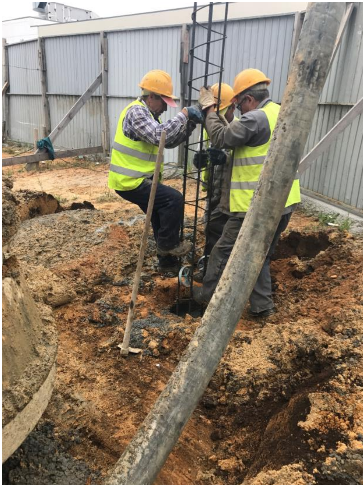
Figura 4.9 – Colocação da estaca
