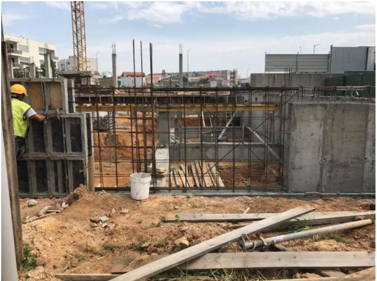
Figura 4.11 – Preparação de betonagem de parede de separação de balneários
