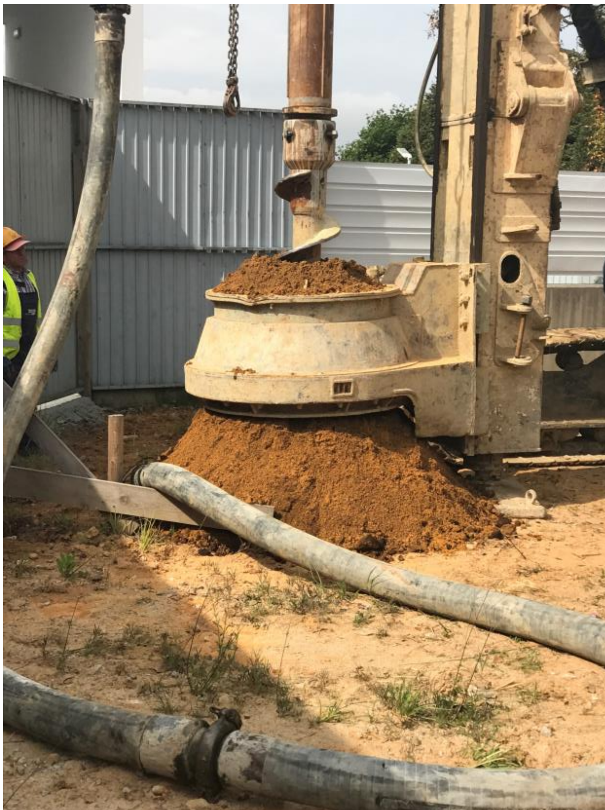
Figura 4.8 – Perfuração do solo e preenchimento com betão
