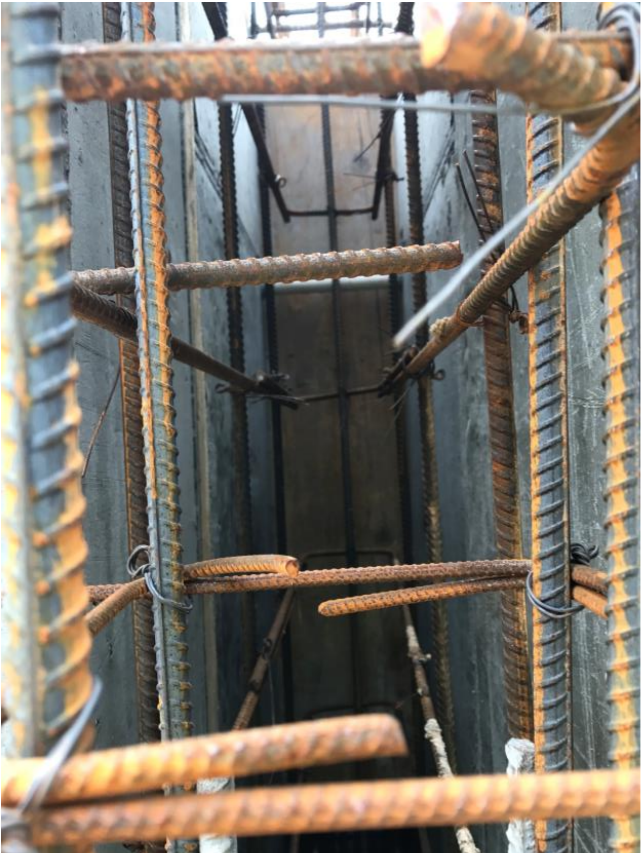
Figura 4.12 – Armaduras no interior de uma parede
