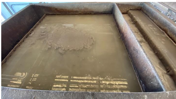
Figura 3.8. Decantador lamelar.
