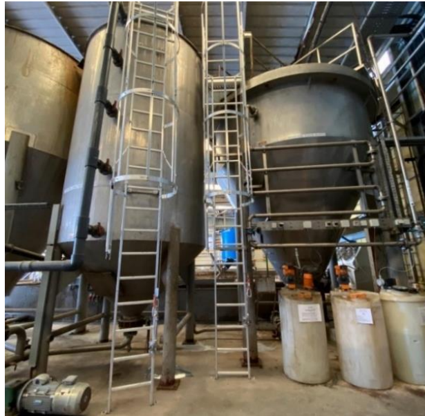
Figura 3.3. Decantador primário (do lado direito) e espessador gravítico (do lado esquerdo).
