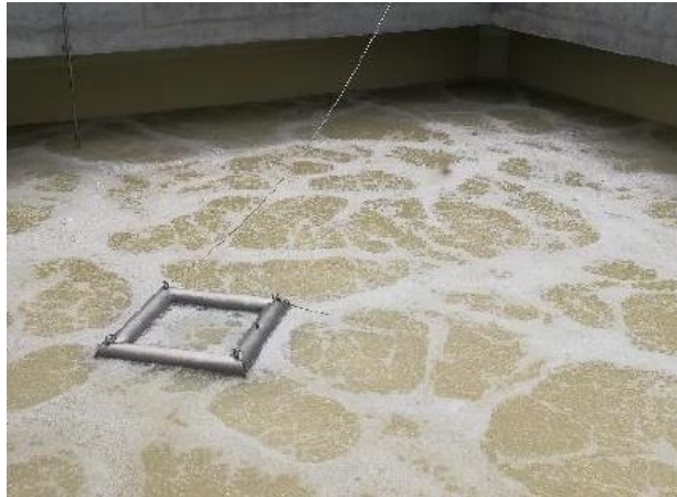
Figura 8.2. Exemplo de um descarregador flutuante VentillaQUA (VentillaQUA, 2022).
