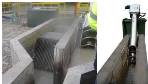
Figura 7.1. Exemplo de uma grade e de um tamisador.
