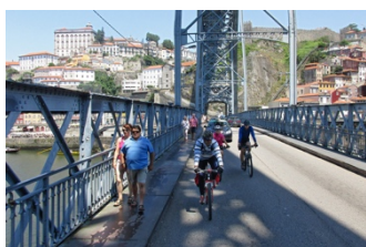
Via banalizada (Fonte: http://images-cdn.impresa.pt )
