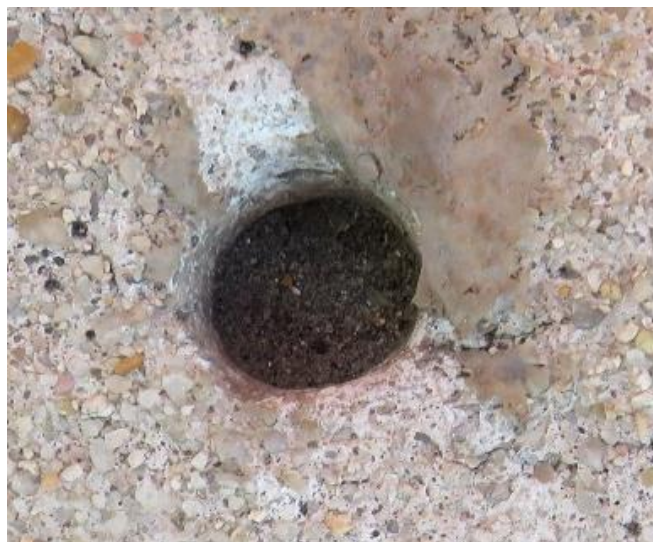
Figura 3.24 – Exemplo de furos para instalação de equipamentos. (Acervo do autor)
