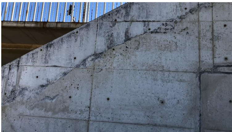
Figura 3.26 – Exemplo de junta de betonagem. (Acervo do autor)
