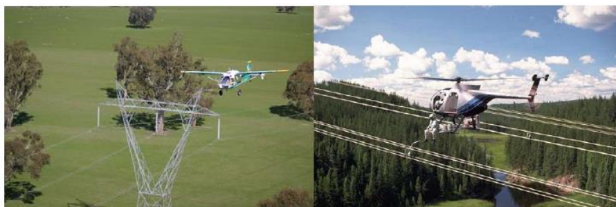
Figura 2.6 – Inspeção de linhas de transmissão de energia elétrica. (Rangel, Kienitz e Brandão, 2009)
