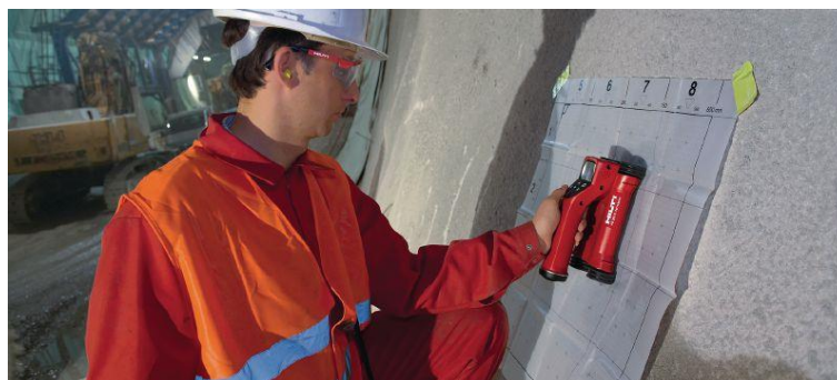
Figura 3.27 – Ensaio de deteção da armadura. (HILTI, 2019)
