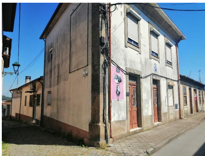
Figura 17 - Fachada da Padaria Costa e Capela, 2022 (Fonte: Autoria própria)
