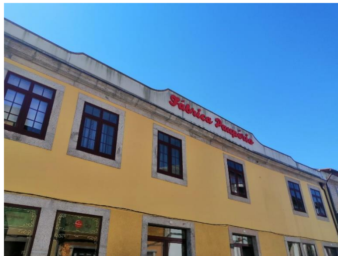
Figura 22 - Fachada da Fábrica Paupério, 2022 (Fonte: Autoria própria)
