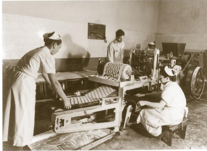
Figura 20 - Máquina de bolachas, Fábrica Paupério, s.d. (Fonte: Fábrica Paupério)
