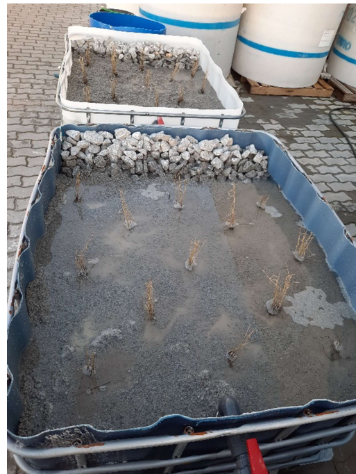
Figura 3.16 – Plantação dos caniços no leito
