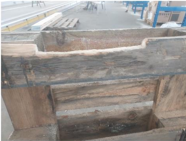
Figura 69 Palete com buraco 20x240 mm e 40x40 mm
