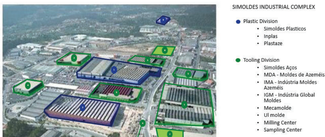
Figura 21 - Zona Industrial de Oliveira de Azeméis, e implantação do Grupo Simoldes
