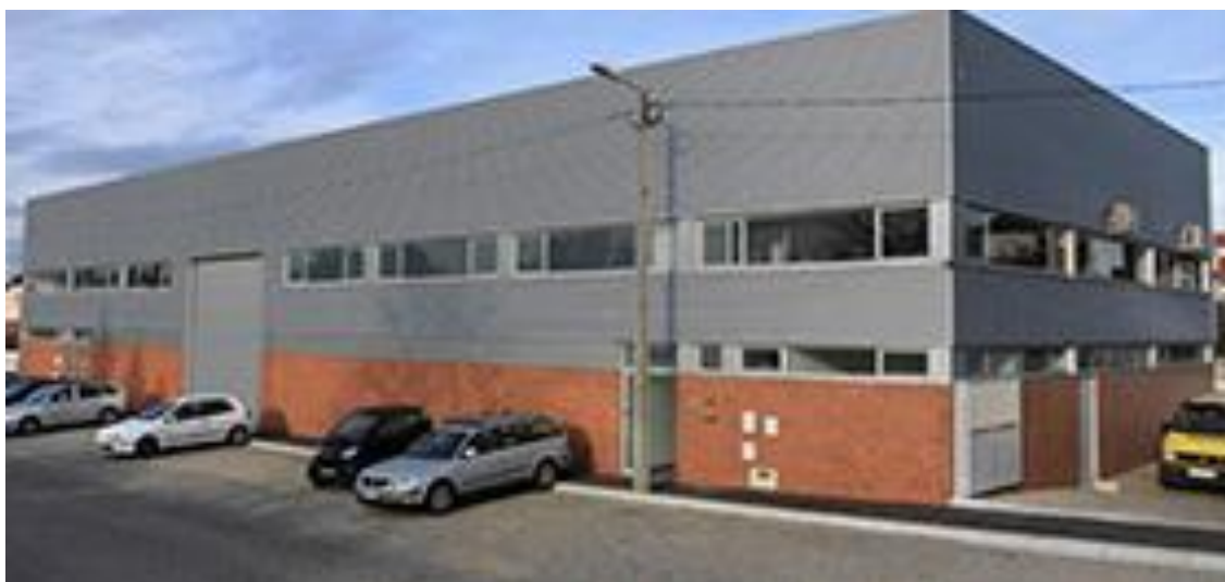
Figura 46 – Vista das instalações da PR-Metal em Folgosa-Maia
