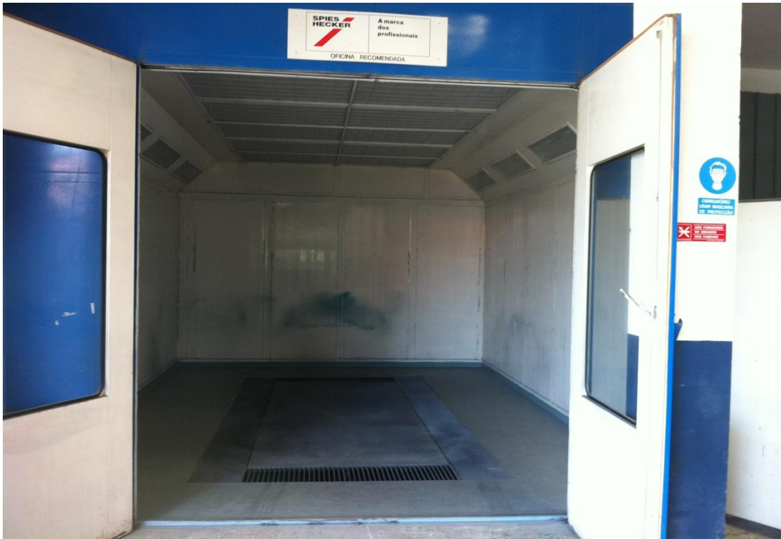
Figura 6 - Estufa de pintura.
