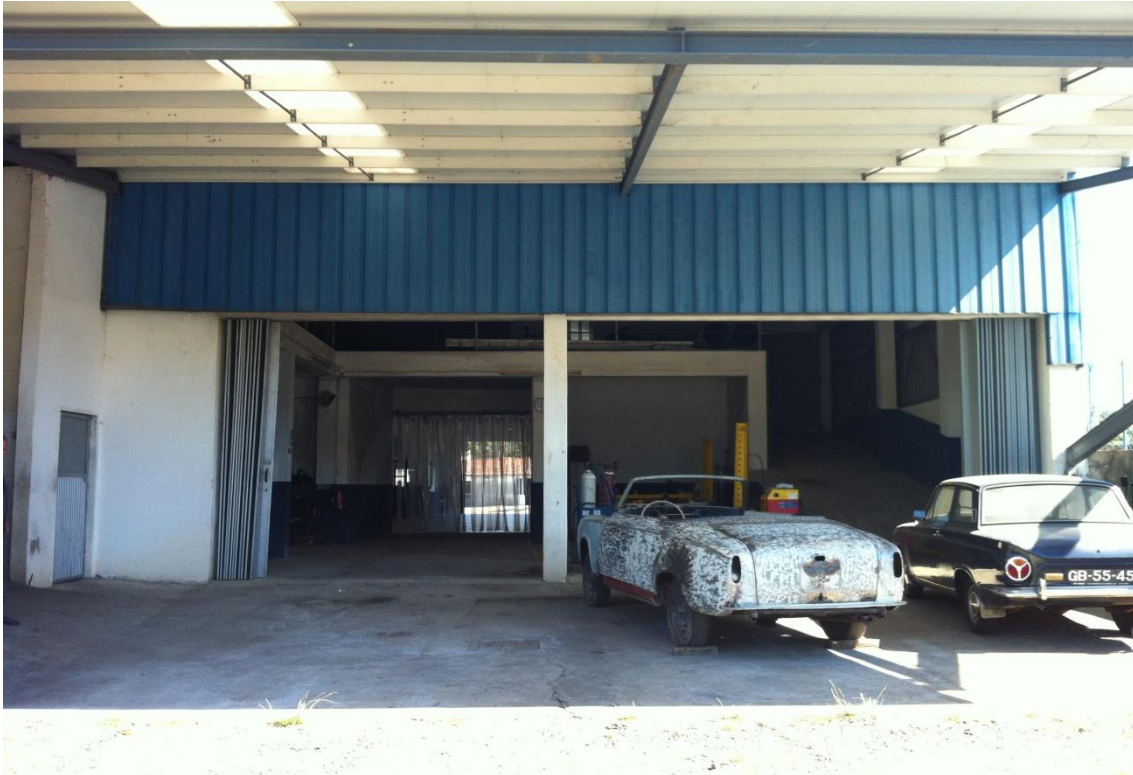
Figura 5 - Área exterior de acesso à secção de chapa e pintura.
