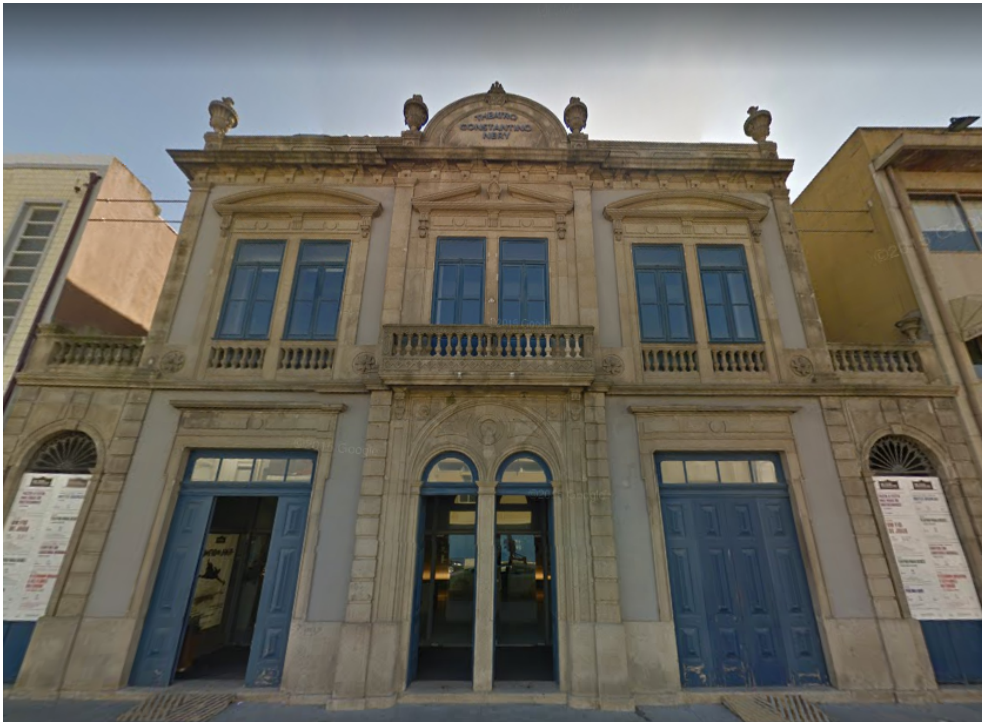
Figura 4 – Fachada atual do antigo Cine-Teatro Constantino Nery
