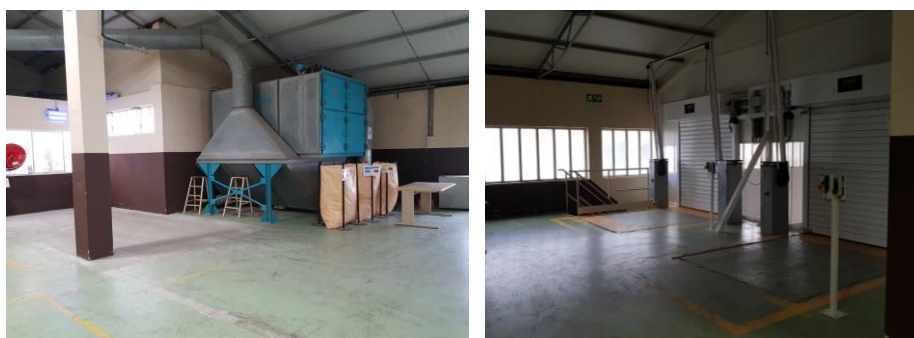
Figura 66 - a) zona de preparação de cargas para expedir e b) cais de carga
