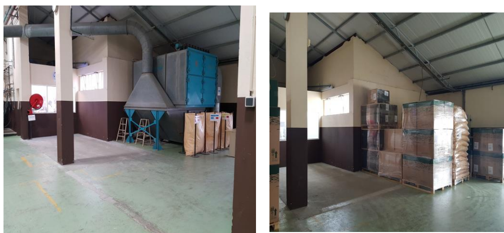
Figura 76 - a) zona de preparação de cargas com o filtro de despoeiramento e b) zona de preparação de cargas após retirada do filtro de despoeiramento (acréscimo de 20 posições de paletes)
