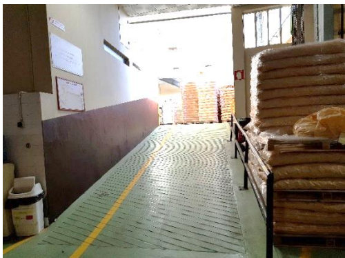
Figura 33 - Rampa de acesso do armazém 1 à zona de produção vista de frente
