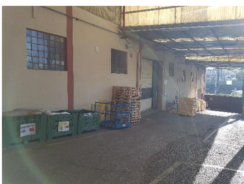
Figura 37 - Troço de acesso aos armazéns 2 e 3
