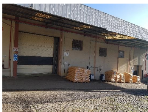
Figura 38 - Portões de acesso ao armazém 2 e 3
