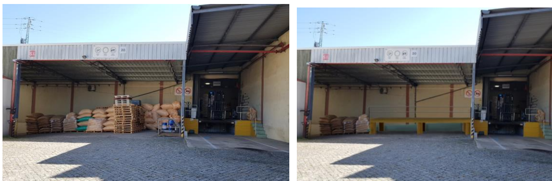
Figura 60 - À esquerda imagem do cais de carga sem a plataforma e à direita, cais de carga com a plataforma
