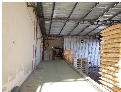
Figura 36 - Rampa de acesso dos armazéns 2 e 3 ao armazém 1
