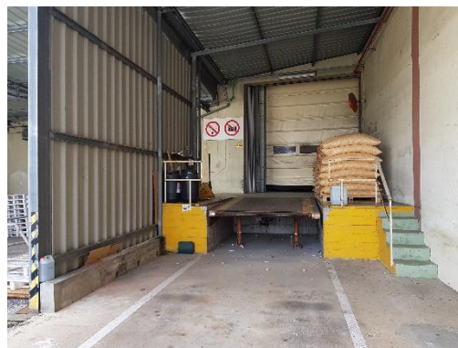
Figura 47 - Cais de receção AD
