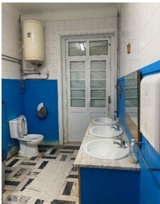
Figura 13- Casa de banho da APC.
