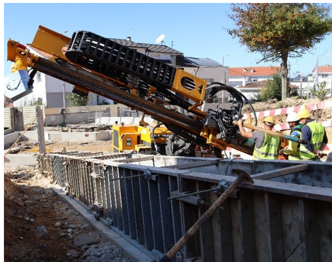
b) Execução dos furos na viga de coroamento para colocação dos cabos de aço das ancoragens
