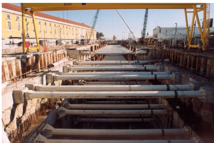
Figura 2.4 – Cortina de estacas escorada na Obra da Estação de Metro do Terreiro do Paço (Lisboa) [6]
