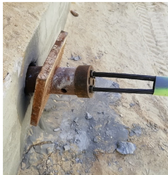
b) Colocação da chapa de descarga da ancoragem, juntamente com a cabeça de ancoragem
