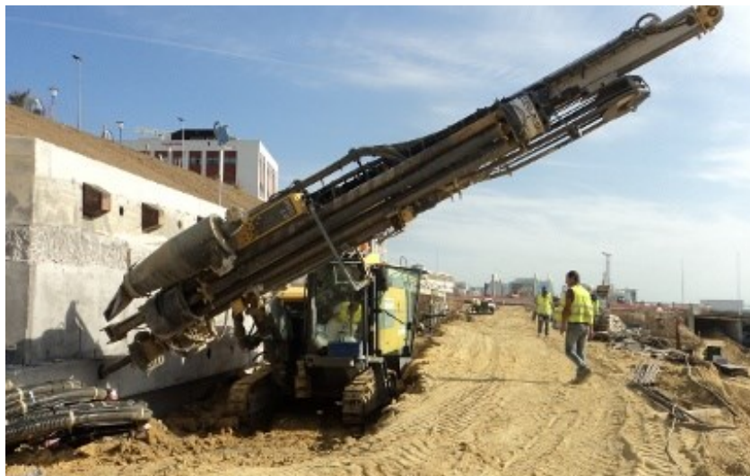
Figura 2.21 – Execução de furo para ancoragens com recurso a equipamento de roto-percussão [19]
