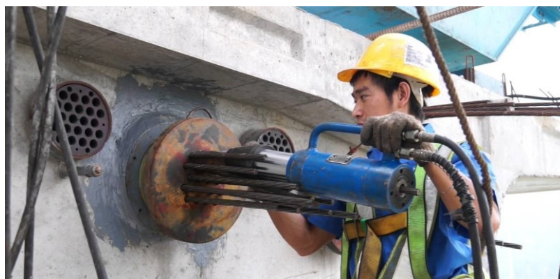
Figura 2.23 – Aplicação do pré-esforço nos cabos de aço utilizando macaco hidráulico [22]
