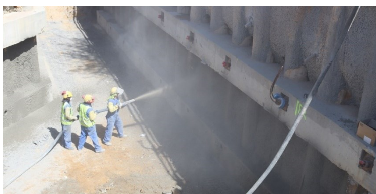
Figura 3.23 – Betonagem da cortina de estacas entre vigas de distribuição, garantindo a selagem do terreno (abril 2022) [21]
