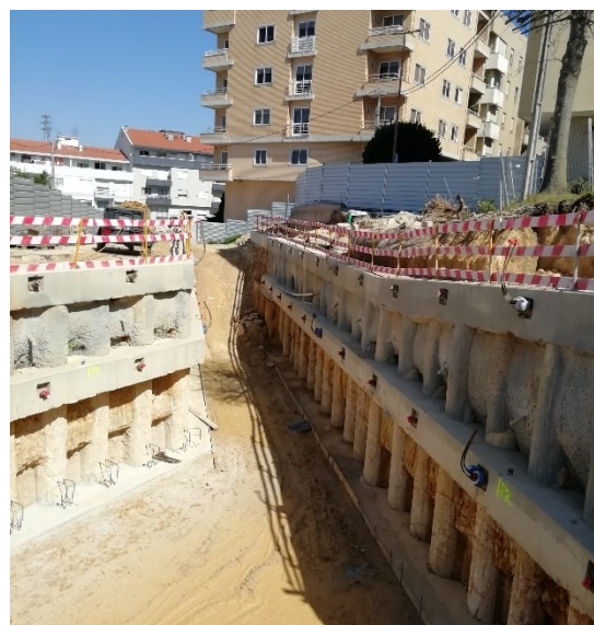
b) Estado de trabalhos da Galeria de Acesso Norte, no mês de abril de 2022
