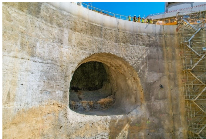
Figura 3.27 – Perspetiva da secção da Galeria de Acesso Norte, executada segundo o método construtivo mineiro (abril 2022) [21]
