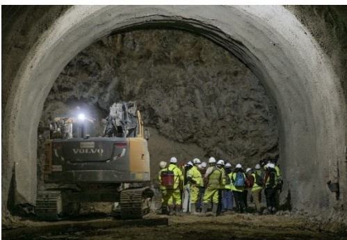
a) Frente de escavação do túnel Norte
