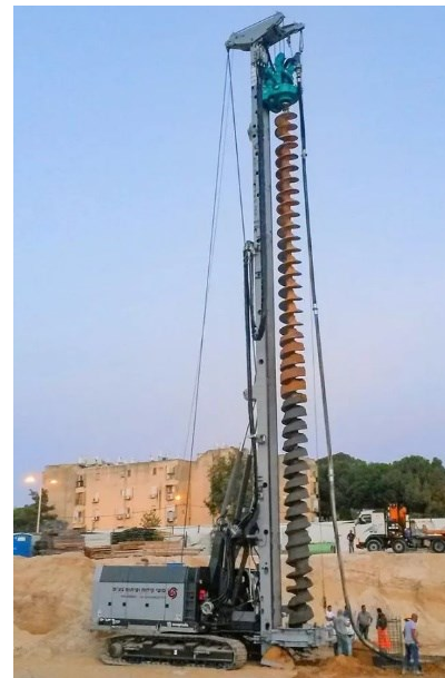
b) Escavação utilizando trado contínuo [13]
