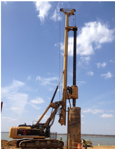
a) Escavação com recurso a tubo moldador [6]
