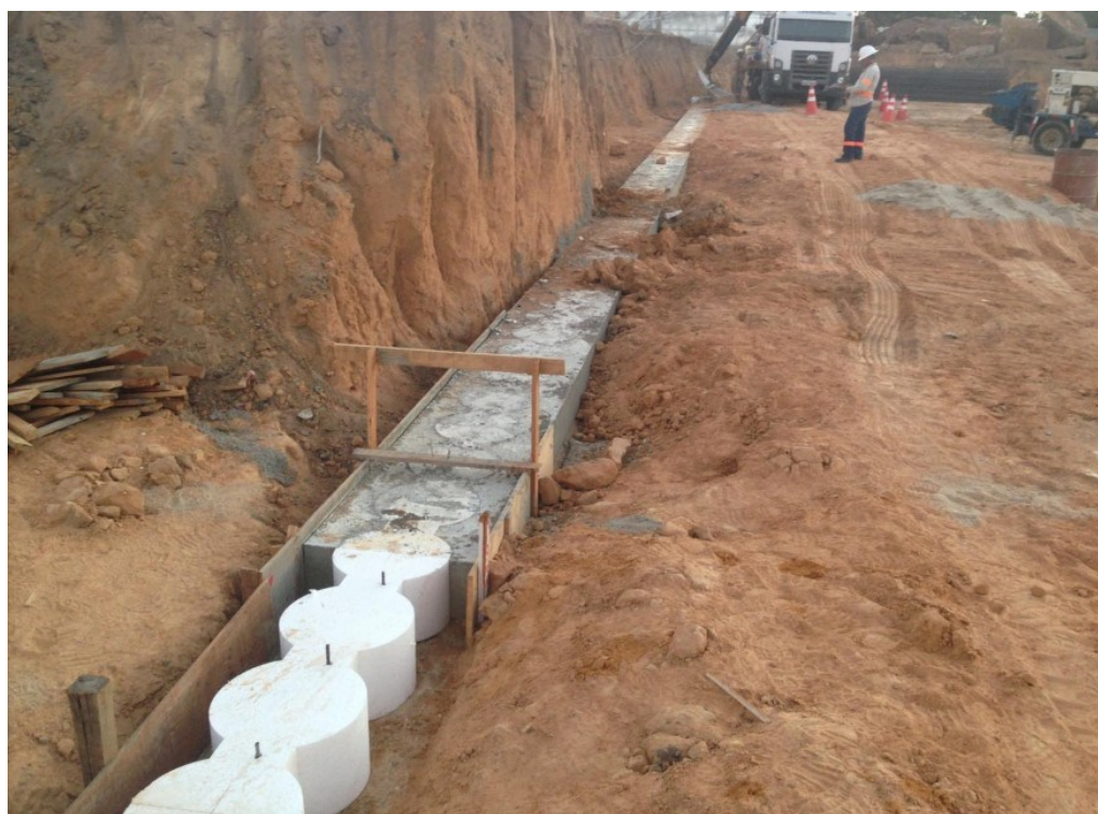
Figura 2.14 – Execução de muro guia para execução de cortina de estacas secantes [11]
