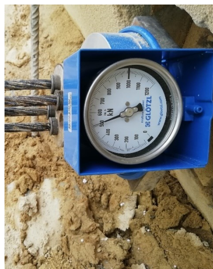
b) Instalação de equipamento de monitorização nas ancoragens – célula de carga
