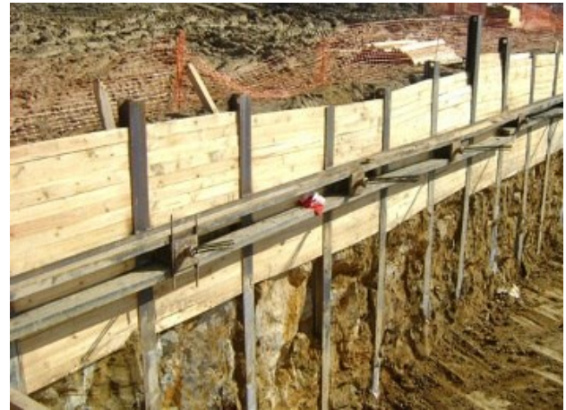
b) Execução de muro de Berlim do tipo provisório
