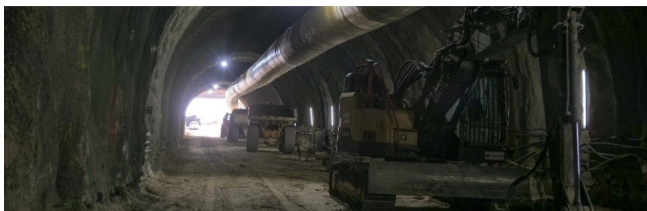
Figura 3.11 – Imagem do interior do túnel Sul (abril 2022) [21]
