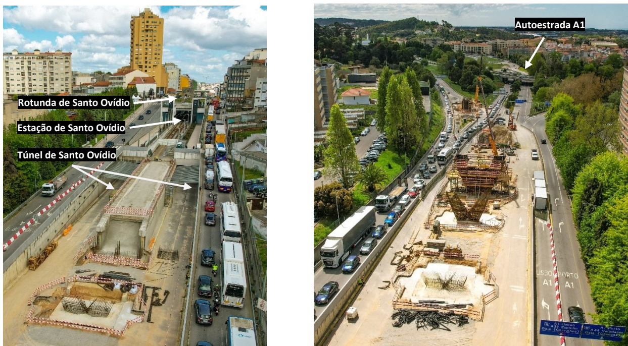
a) Perspetiva Norte do arranque do viaduto, na zona de Santo Ovídio
