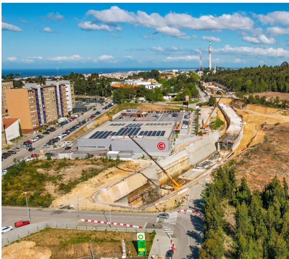
Figura 3.16 – Imagem aérea do trajeto de linha que se desenvolve em módulos fechados, atravessando várias vias de circulação rodoviária (abril 2022) [21]
