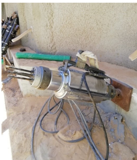
a) Aplicação de pré-esforço nas ancoragens através de macaco hidráulico
