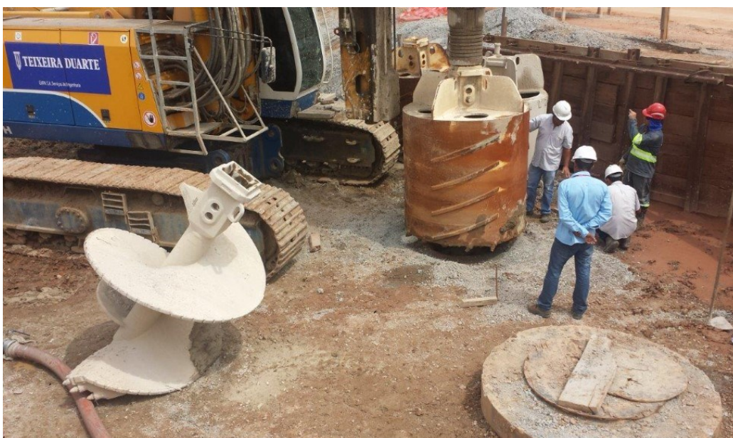
Figura 2.10 – Execução de estacas para fundação indireta de pilares na ponte de Itapaiúna, São Paulo, Brasil [6]
