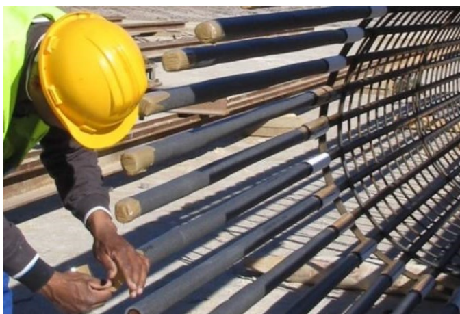
a) Colocação de camisas na extremidade das armaduras,
