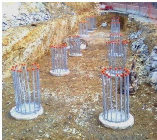
b) Aspeto final de um conjunto de estacas saneadas
