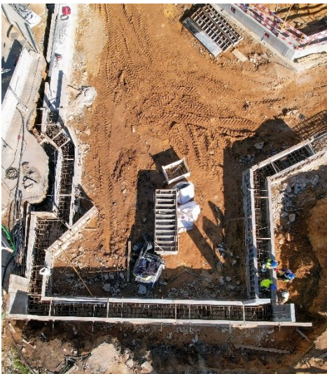
a) Colocação de armadura e cofragem para execução da viga de coroamento
