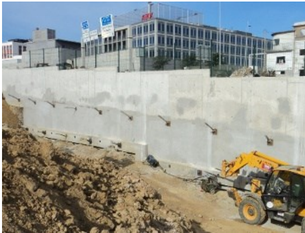
a) Execução de muro de Berlim do tipo definitivo
