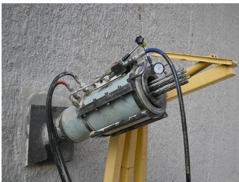
Figura 2.24 – Equipamento instalado numa ancoragem para realização de ensaios de controle [24]
