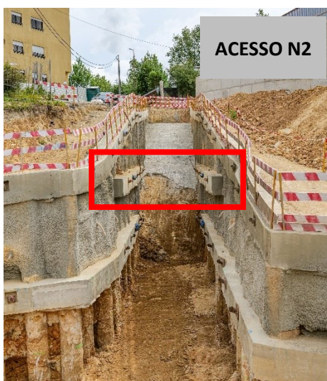
Figura 3.34 – Vigas de distribuição do 1º nível (identificadas a vermelho) localizadas no acesso N2 da Galeria de Acesso Norte (maio 2022) [21]
