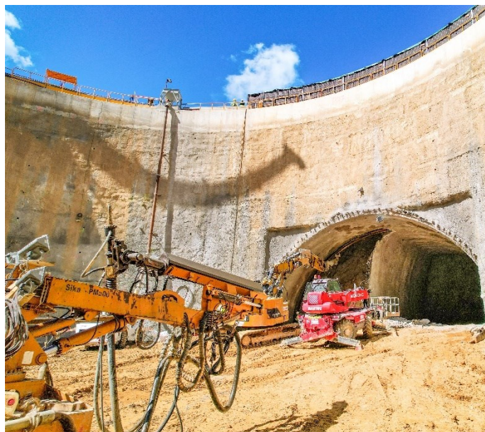
b) Perspetiva do interior do Poço da Estação Manuel Leão, direcionado para a Galeria do Cais Norte
