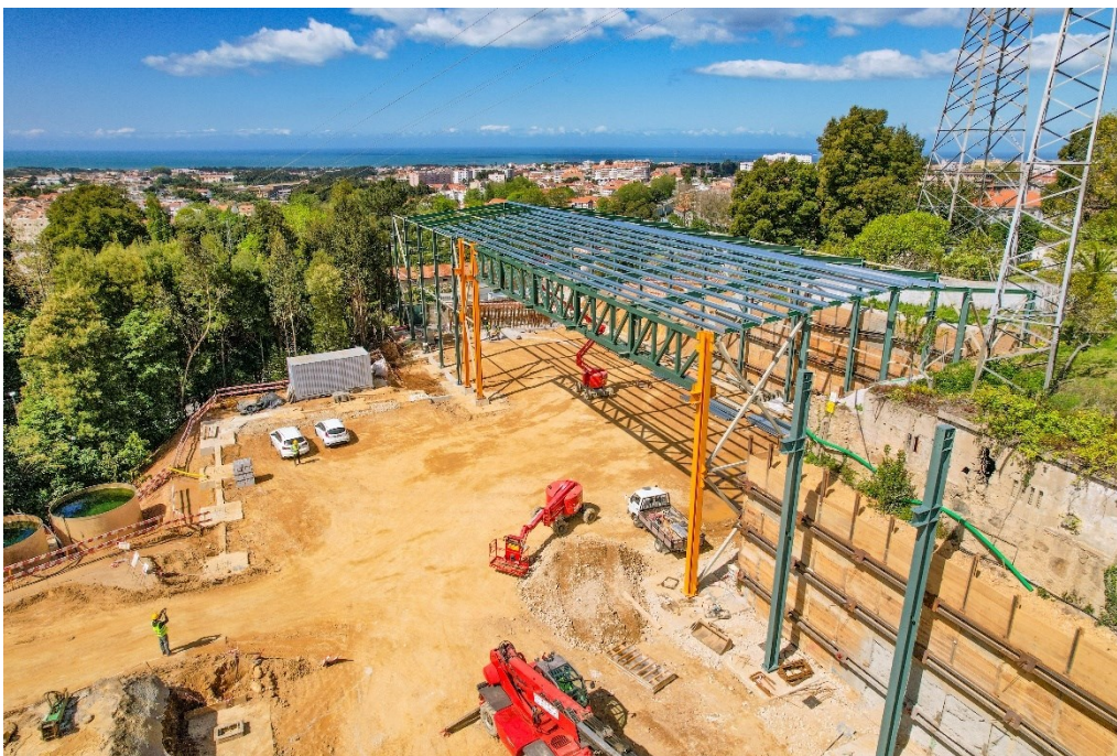
Figura 3.8 – Execução do parque de deslize, onde serão montadas as peças metálicas e, de seguida, colocadas sucessivamente, a partir do encontro (abril 2022) [21]
