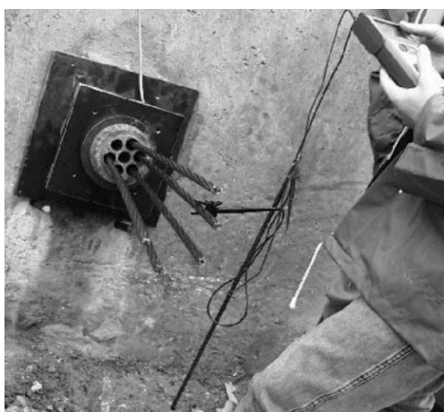
a) Medição da resistividade elétrica de uma ancoragem
