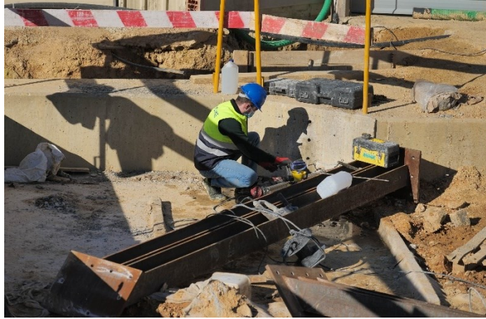
Figura 3.26 – Instalação das escoras metálicas na viga de coroamento (abril 2022) [21]
