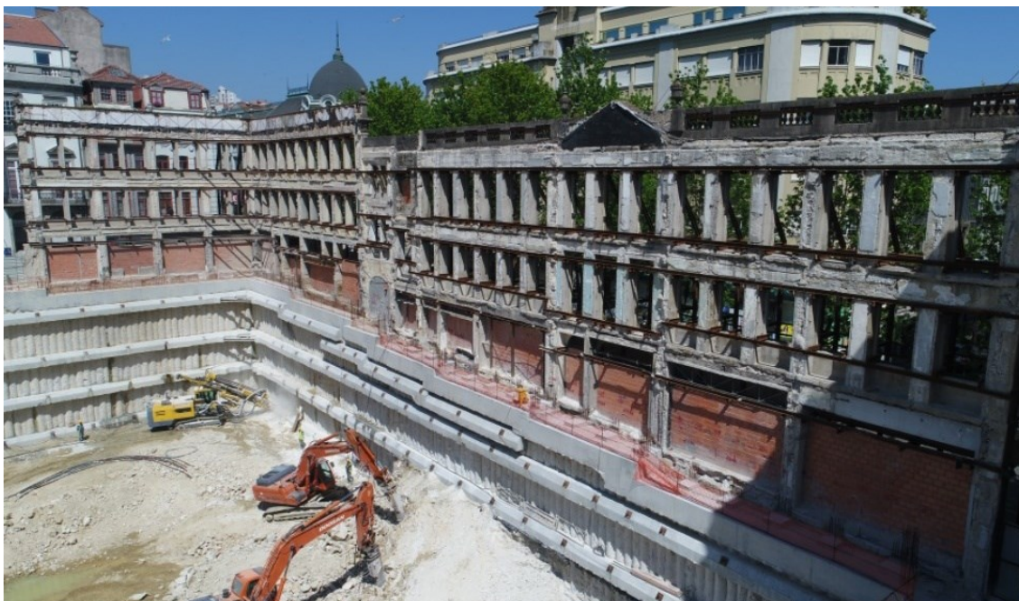
Figura 2.9 – Cortina de estacas ancorada – Quarteirão D. João I, Porto [6]
