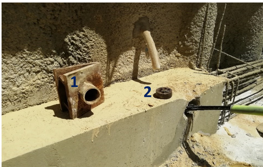
Figura 3.33 – Injeção de calda no furo, com a ancoragem colocada, para estabelecer a ligação entre este elemento e o maciço rochoso; à esquerda, os acessórios metálicos chapa de descarga (1) e cabeça de ancoragem (2) (abril 2022)
