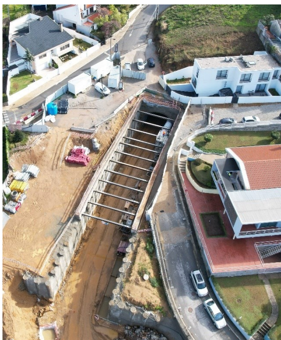
a) Zona do emboque Norte
