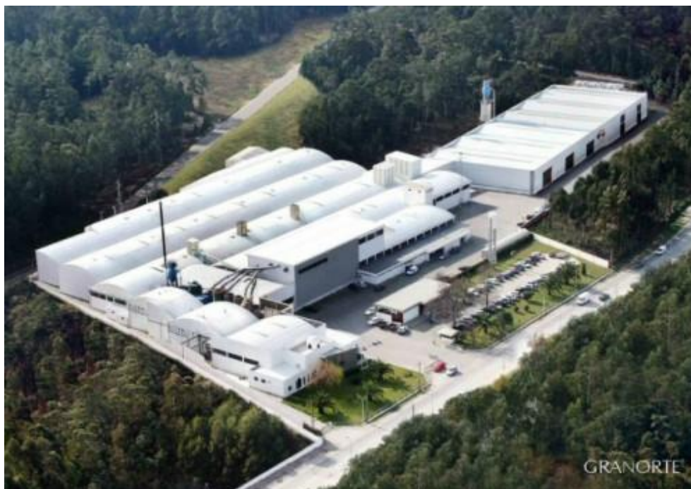
Figura 1 – Vista aérea da GRANORTE
