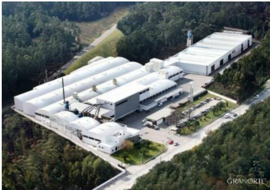
Figura 4. Vista aérea da GRANORTE
