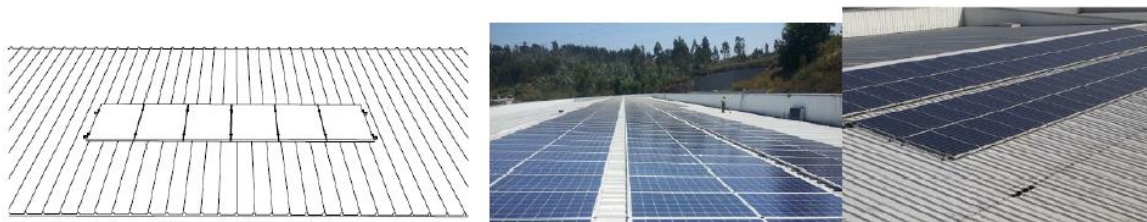
Figura 71 Fixação de PF diretamente sobre os painéis da cobertura
