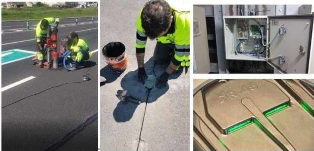
Figura 58 Trabalhos de instalação dos marcadores de LED no pavimento
