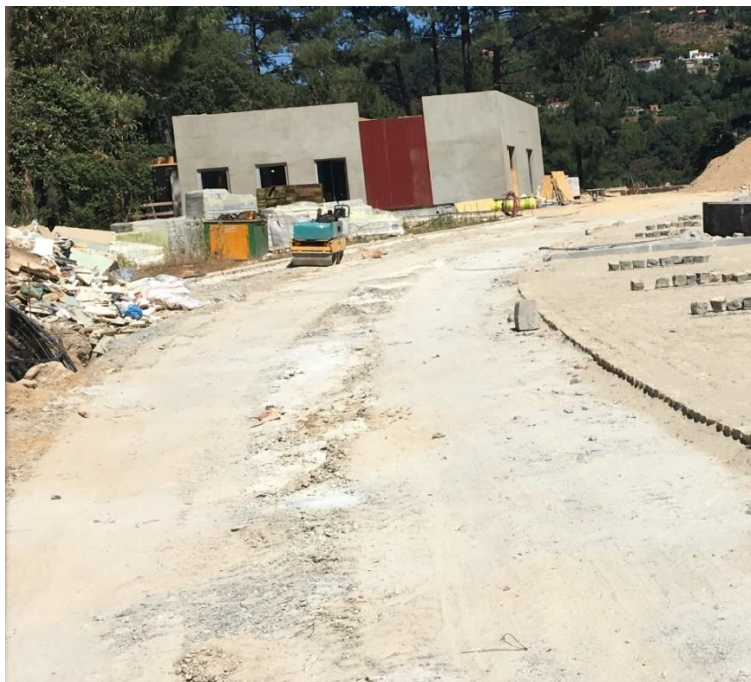
Figura 1.7 – Lado Norte da área de intervenção
