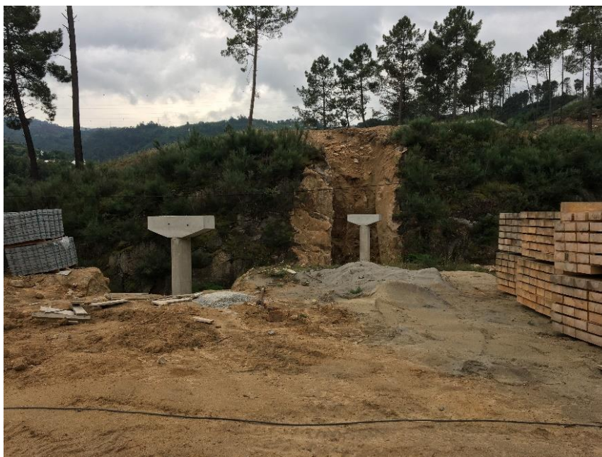
Figura 1.8 – Ligação dos dois lados do parque por uma ponte pedonal
