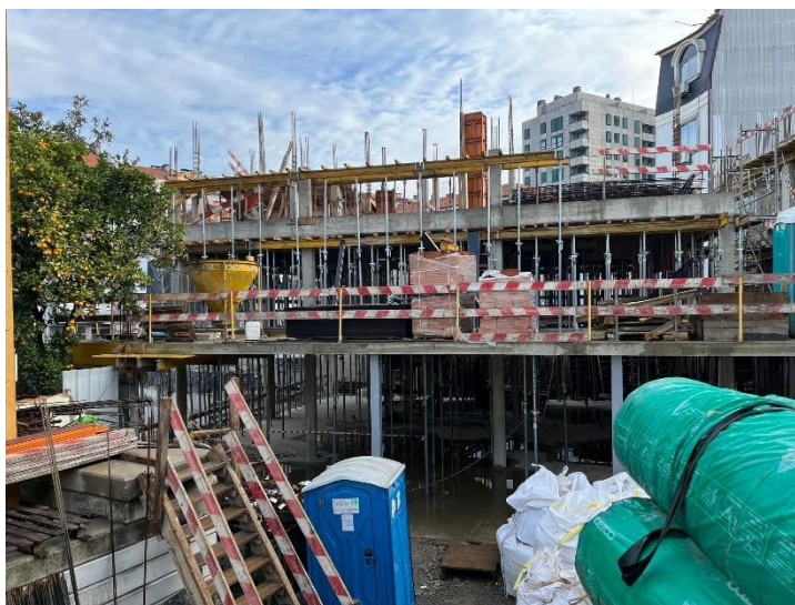
Figura 3.7 - Estado de execução bloco B
