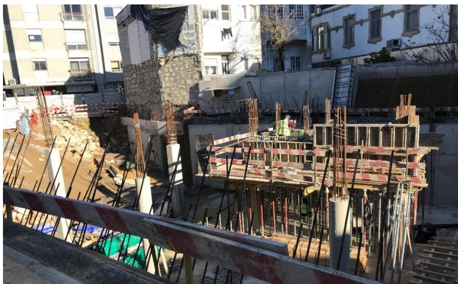
Figura 3.4 - Início de execução de piso 0 bloco B
