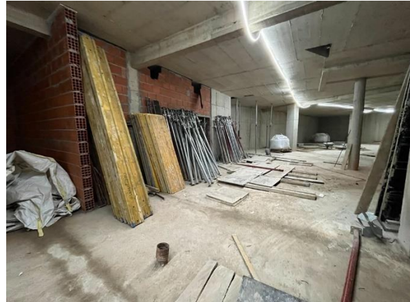
Figura 3.13 – Estado de limpeza pós execução no local dos equipamentos utilizados
