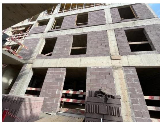
Figura 3.17 - Estado de execução de fachada Bloco C
