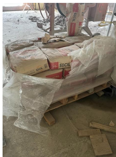
Figura 3.15 – Exemplo de registo de apoio ao controlo de cimento
