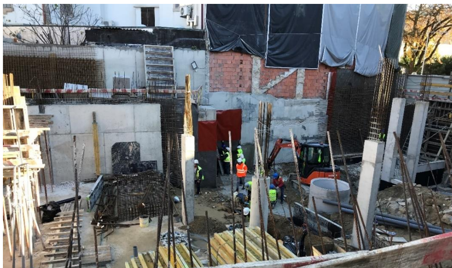
Figura 3.3 - Escavação/Execução de sapatas bloco C
