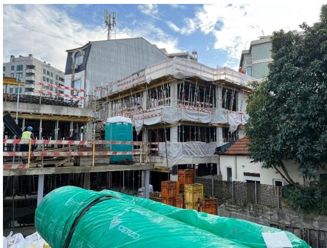
Figura 3.5 - Estado de execução bloco C
