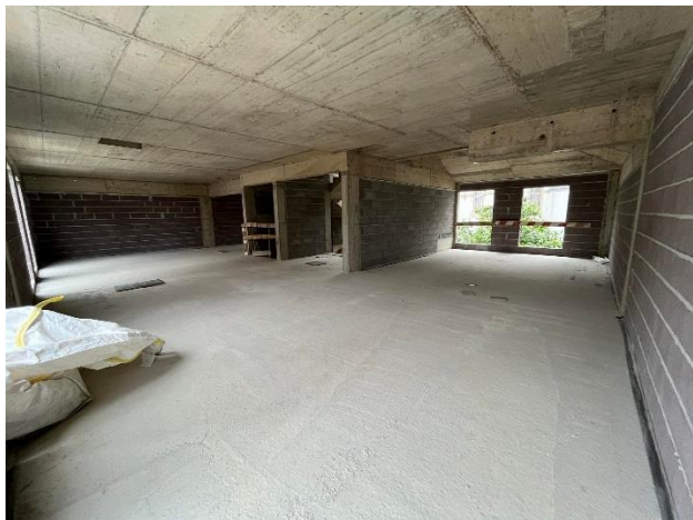
a) Registo alvenaria Bloco B Piso 2
