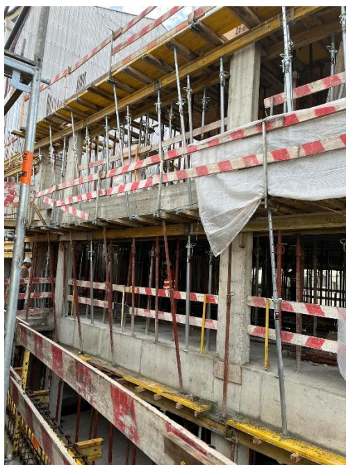
Figura 3.6 - Escoras e cofragem gerais e preparação para execução de Laje Piso 3
