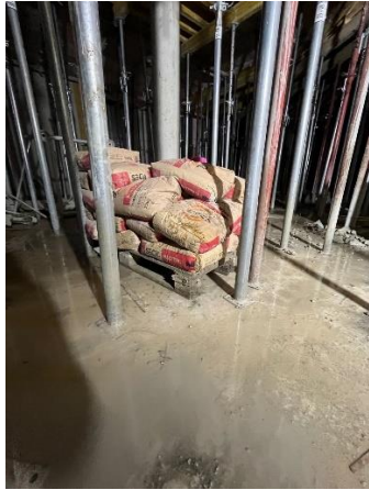
Figura 3.12 – Estado cave Bloco A durante execução
