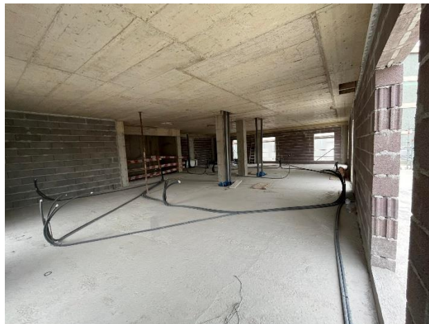
b) Registo alvenaria Bloco C Piso 3
