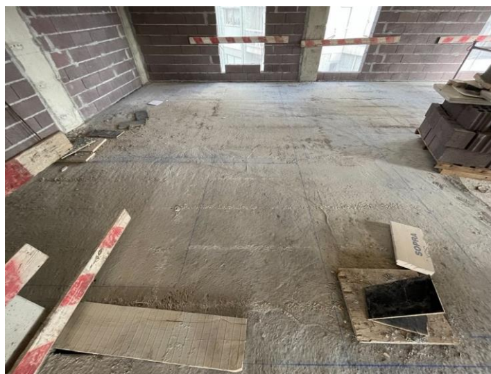
Figura 2.4 – Marcação de posição de paredes interiores segundo preparações
