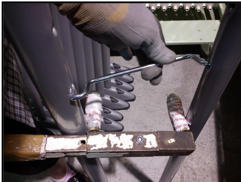
FIGURA 70 - OPERAÇÃO DE COLOCAR O ARAME
