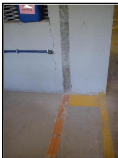
FIGURA 74 - ESPAÇO OBTIDO APÓS REMOVER A PAREDE
