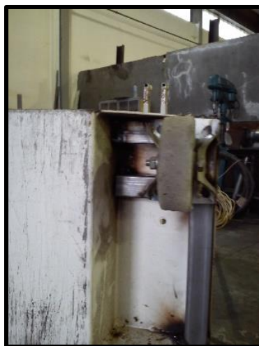
FIGURA 22 - CARRO COM RODA JÁ SOLDADA AOS REFORÇOS APLICADOS
