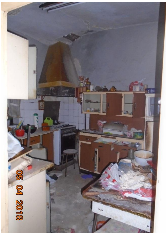
a) Armários deteriorados, sujos e partidos.
