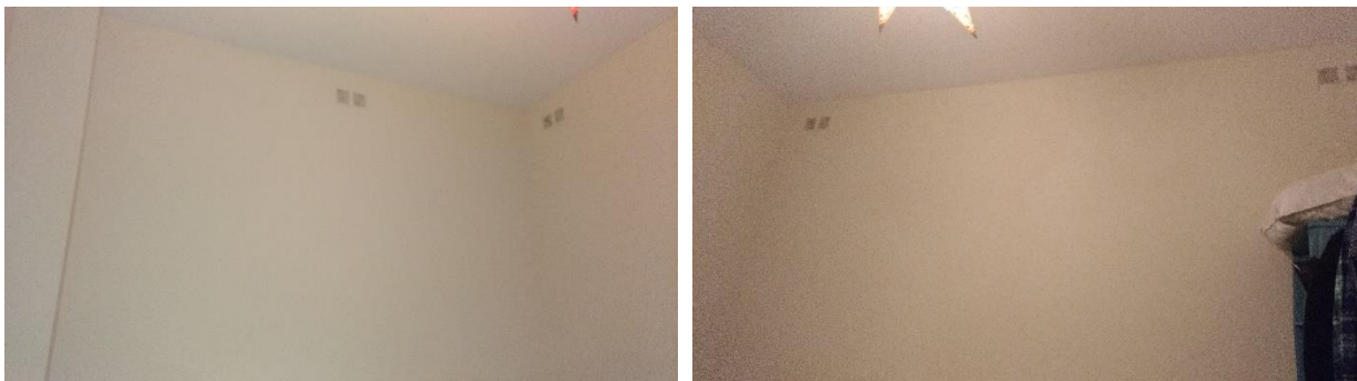
a) Parede voltada a norte.
