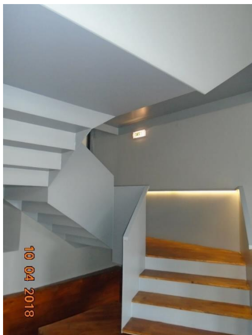
a) Escadaria e guardas metálicas com patins revestidos a madeira
