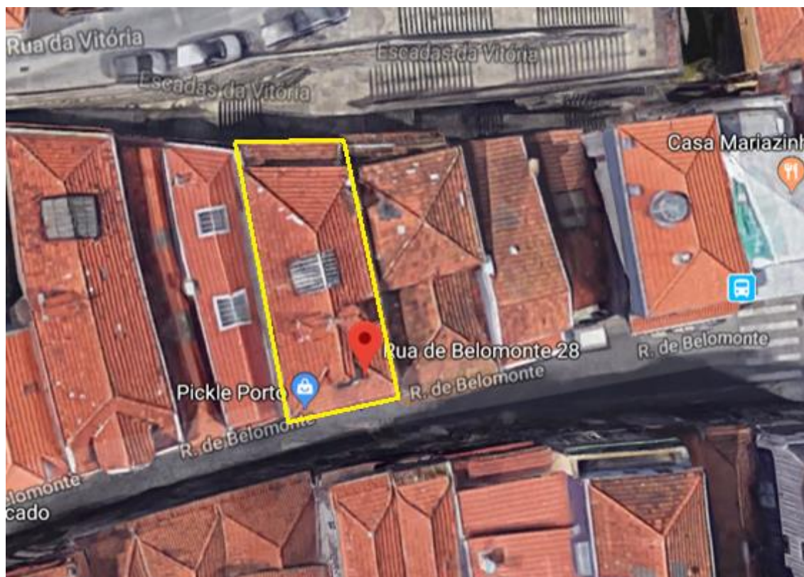
Figura 4.1 – Marcação do edifício [5].
