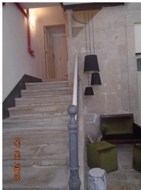
b) Escadaria em pedra com guardas em madeira
