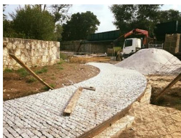
Imagem 12 – Ecovia do Rio Âncora: fase de construção
