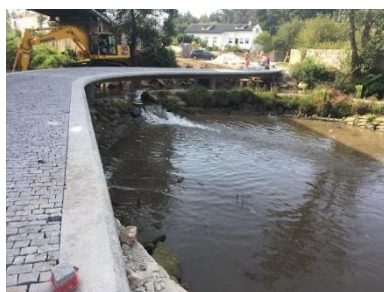
Imagem 13 – Ecovia do Rio Âncora: ponte em fase de construção
