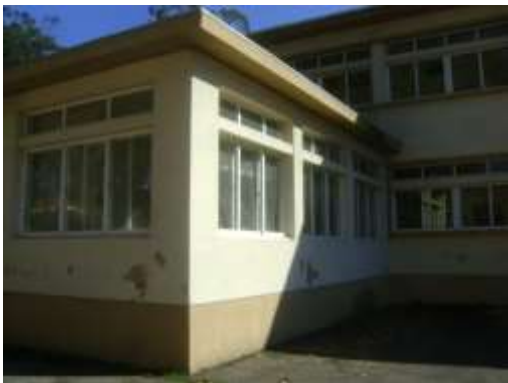
Figura 29 – Diedro entre a cozinha e a via vertical de evacuação.
