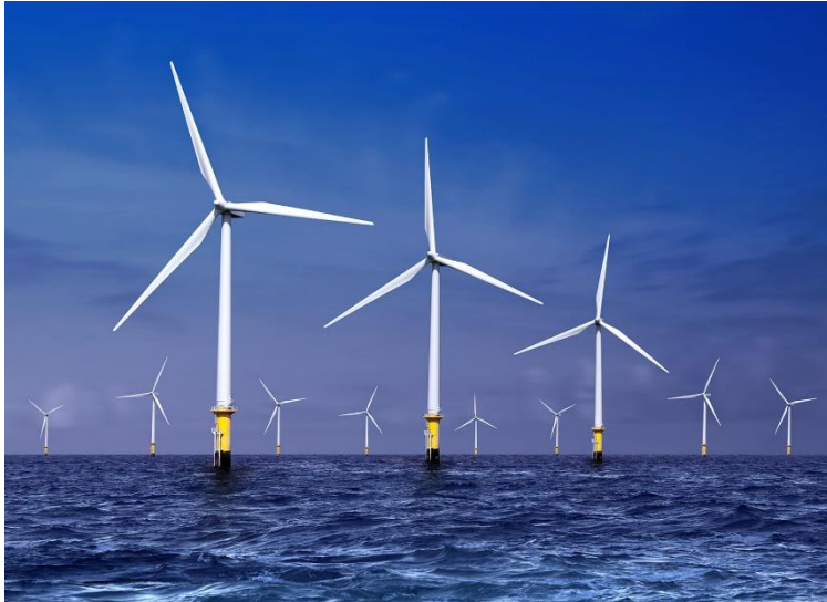
Figura 4- Aerogerador de eixo horizontal
