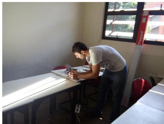
Figura 44: Adaptação da lâmpada de LED à armadura original
