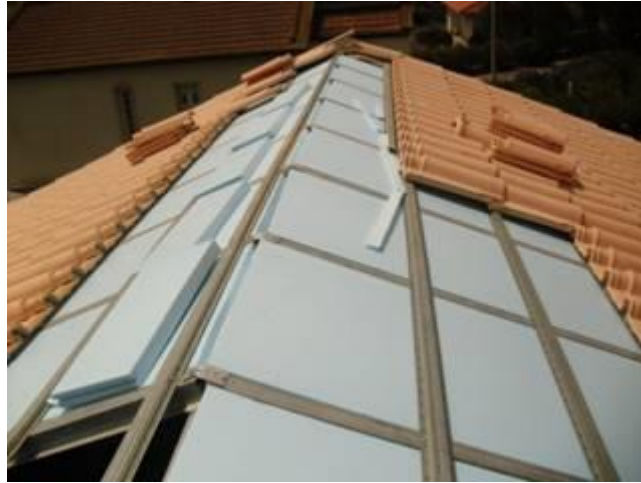
Figura 6 - Cobertura com isolamento
