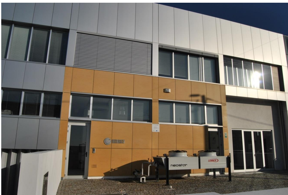
Figura 12 - Fachada frontal do ECOTERMOLAB
