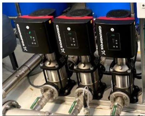
Figura 31 - Grupo Hidropressor
