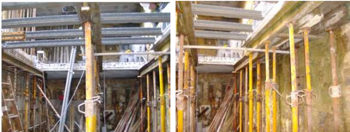
Figura 66- Escoramento de vigas e pisos
