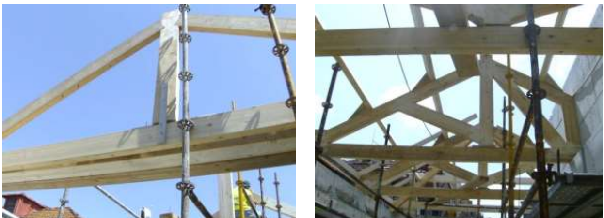
Figura 70- Execução da cobertura
