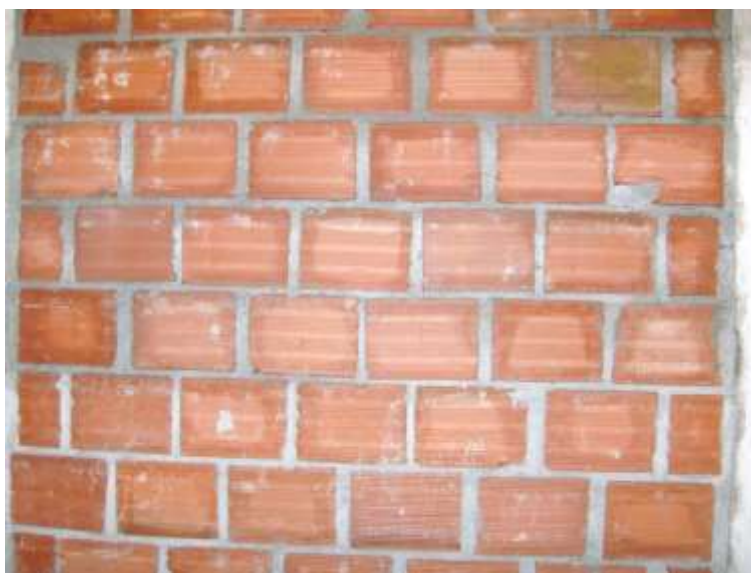
Figura 42- Parede de alvenaria de tijolo
