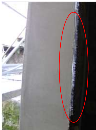
Figura 45- Pormenor da ombreira com rede de fibra de vidro
