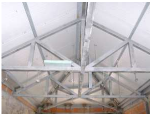
Figura 60- Estrutura metálica da cobertura
