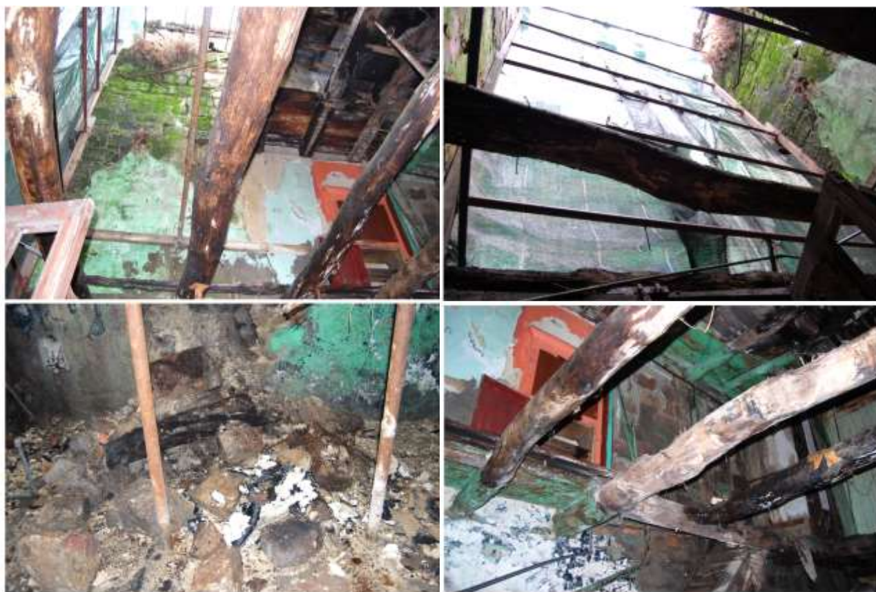
Figura 24- Interior dos edifícios existentes antes da empreitada [20]
