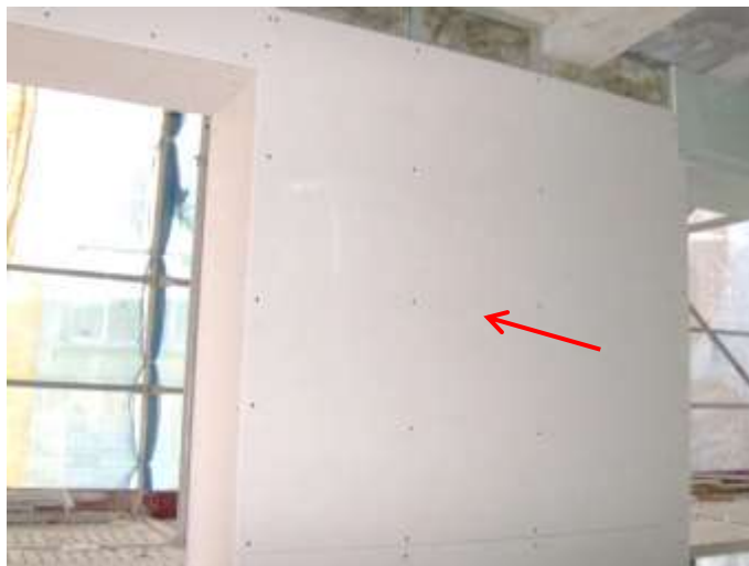
Figura 48- Parede revestida com placas de gesso cartonado
