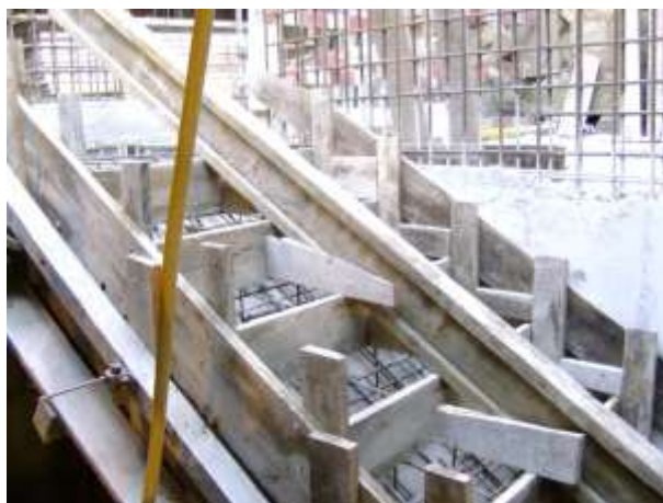
Figura 67- Laje de escada armada e cofrada
