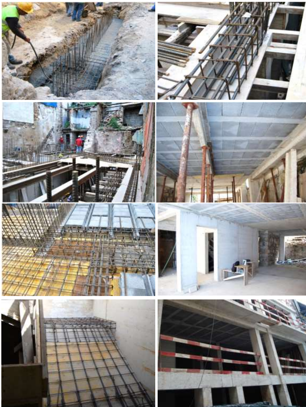
Figura 27- Diferentes fases dos trabalhos estruturais [20]
