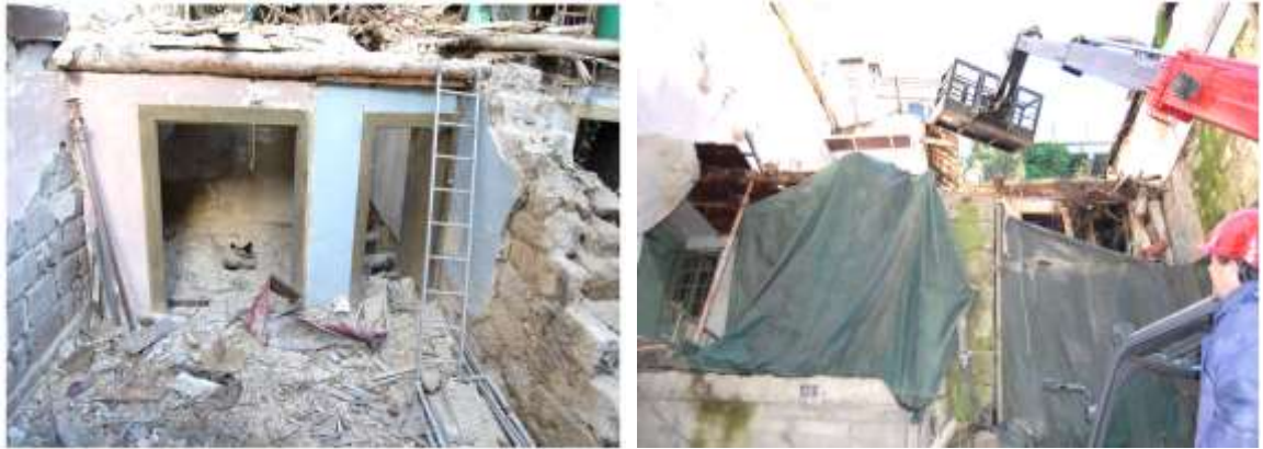
Figura 26- Trabalhos de Limpeza e remoção de entulhos [20]
