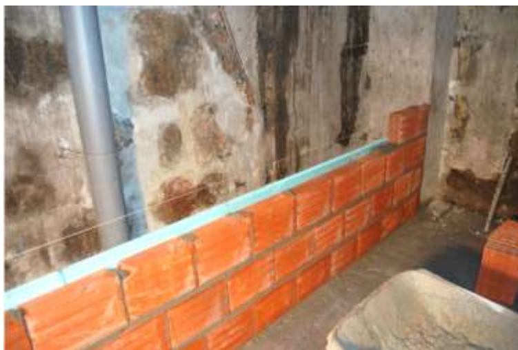
Figura 41- Execução da parede de alvenaria de tijolo (Fonte: Porto Vivo, SRU)
