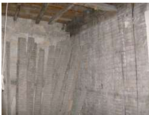
Figura 17- Parede interior de tabique
