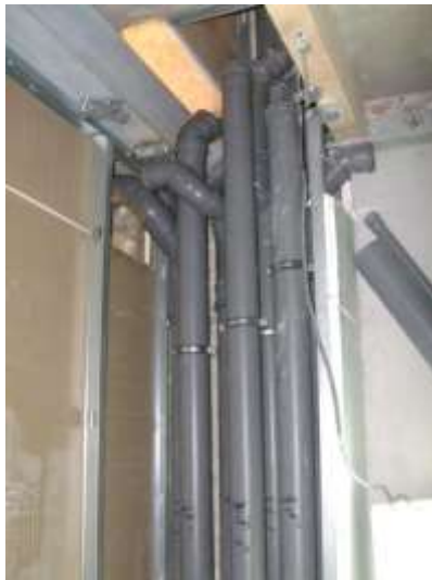
Figura 63- Tubagens para a rede de esgotos
