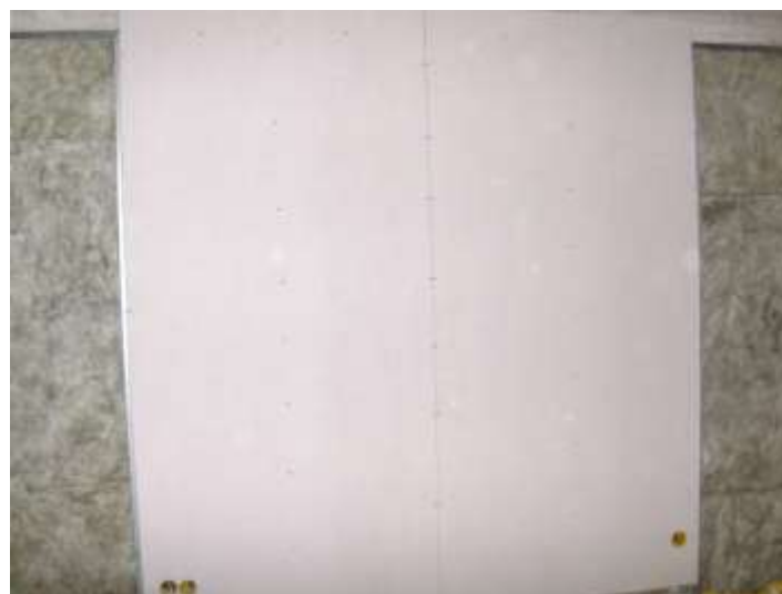
Figura 47- Montagem das placas de gesso cartonado
