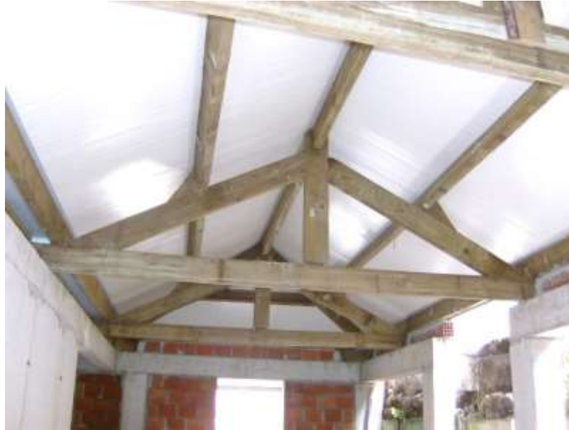
Figura 29-Pormenor da asna em madeira
