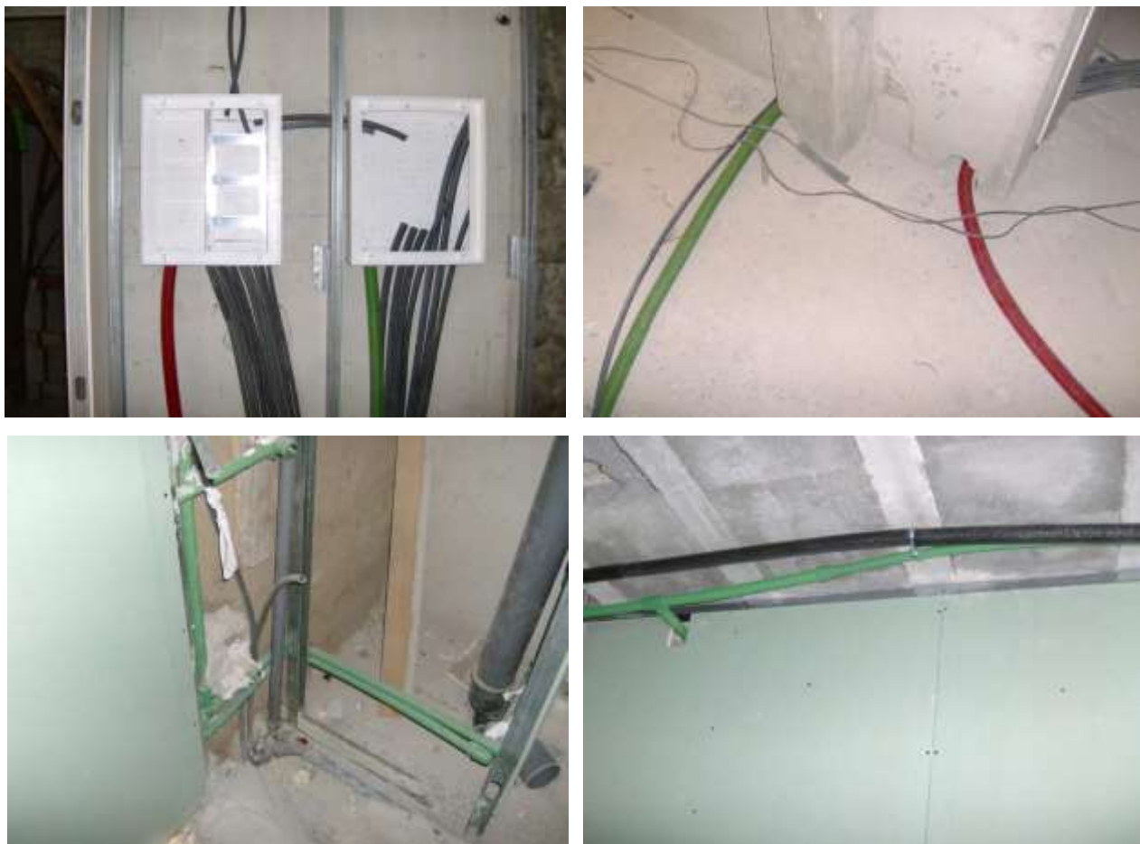
Figura 50 - Instalação das infraestruturas
