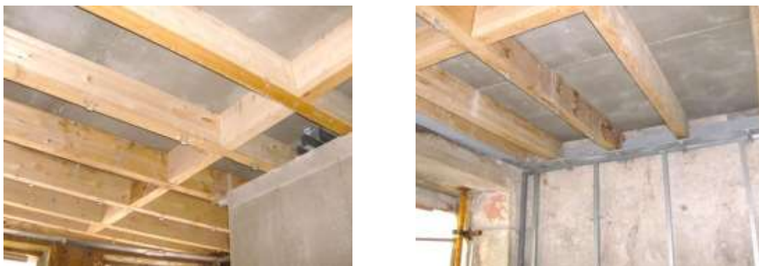
Figura 57- Vigamento de madeira
