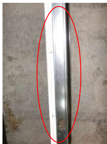
Figura 59- Pormenor da parede divisória, com aplicação das placas de gesso cartonado
