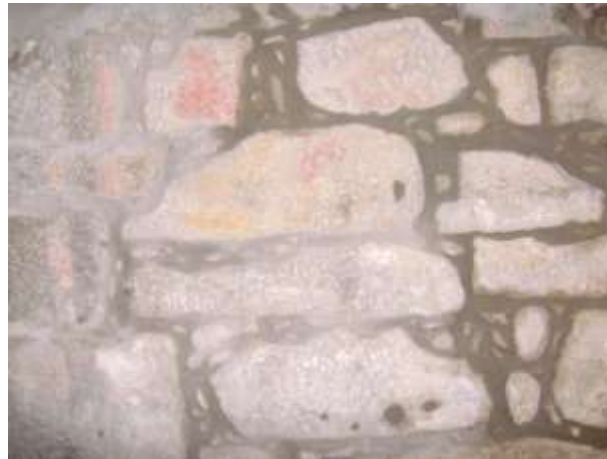
Figura 43- Parede interior em pedra natural
