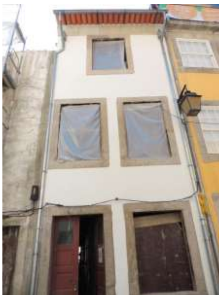
Figura 64- Fachada do Projeto 7
