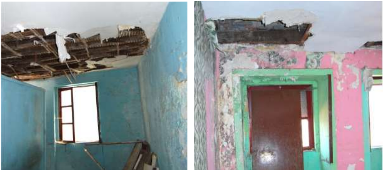
Figura 56- Interior do edifício antes da reconstrução [25]
