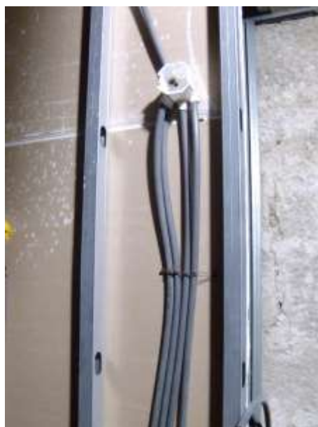
Figura 61- Instalação de rede elétrica
