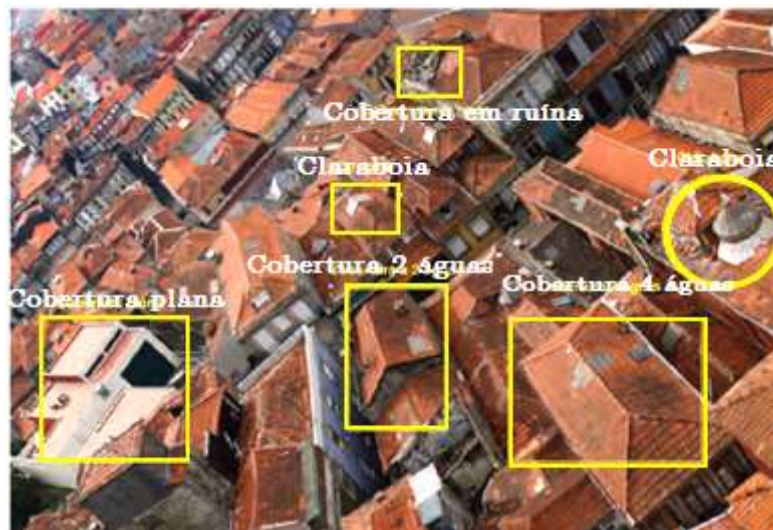
Figura 20- Coberturas de edifícios do Centro Histórico do Porto [15]
