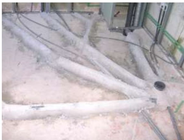
Figura 52- Tubagens de saneamento básico
