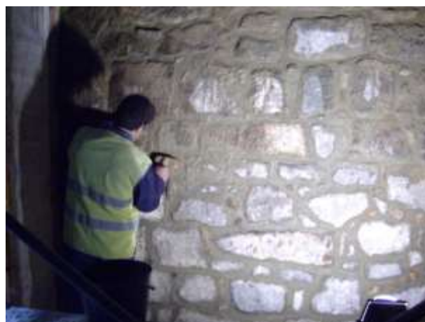
Figura 44- Limpeza da parede de granito
