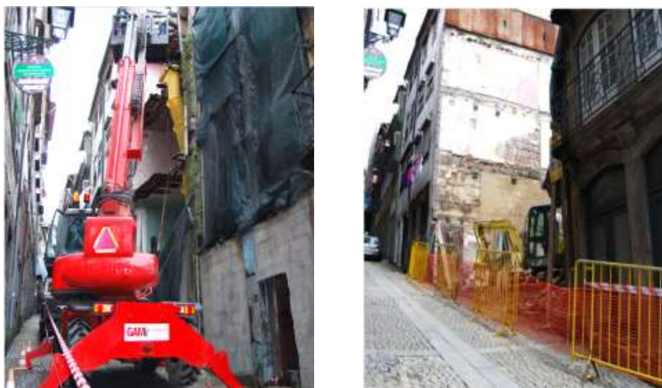
Figura 25 - Trabalhos de demolição e limpeza [20]
