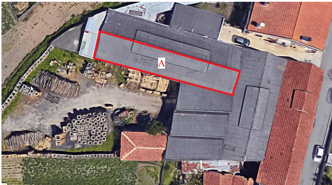
Figura 56 - Definição do local de instalação dos painéis solares
