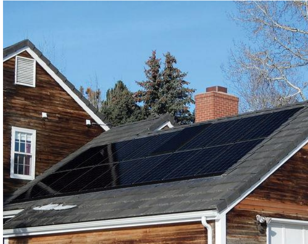
Figura 41 - Estrutura telhado inclinado [42]
