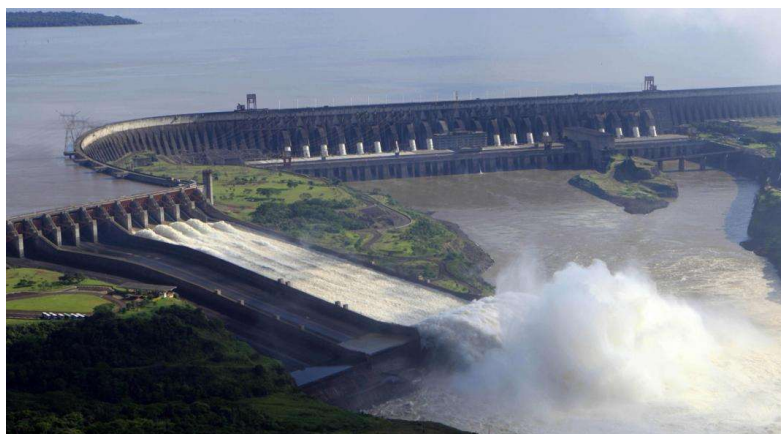
Figura 43- Central Hidroelétrica de Itaipu.
