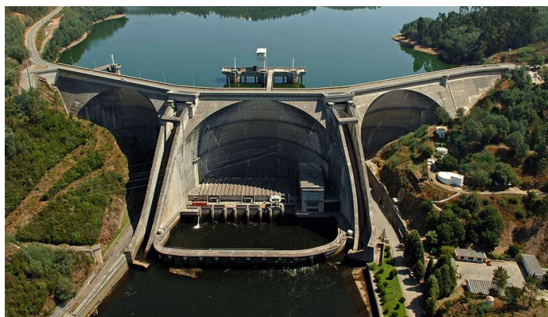
Figura 44- Central Hidroelétrica da Aguieira
