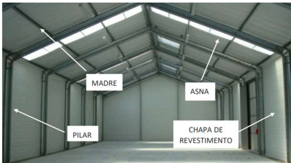
Figura 1 - Pavilhão metálico (adaptado de [6])
