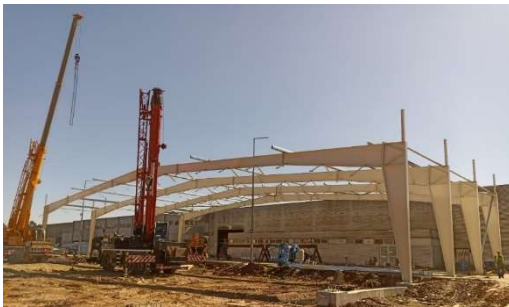
Figura 6 - Pórtico em PRS (elaboração própria)
