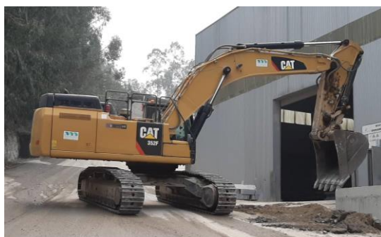
Figura 22 - Retroescavadora (fotografia tirada na pedreira da Nicolau de Macedo)
