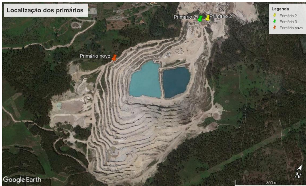
Figura 33 - Localização do primários atuais e do primário novo, retirado de Google Earth Pro
