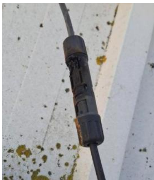
Figura 13 - Desconexão dos conectores MC4 (manutenção corretiva do fornecedor)
