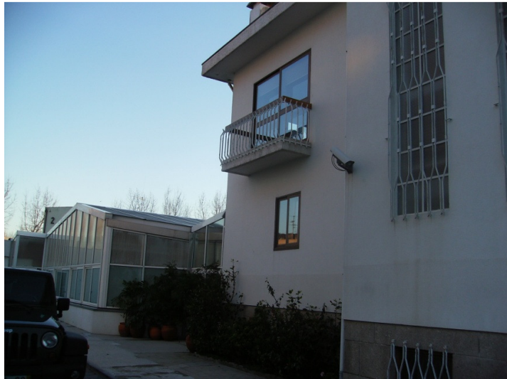
Figura 3. 6 – Fachada orientada a Nordeste
