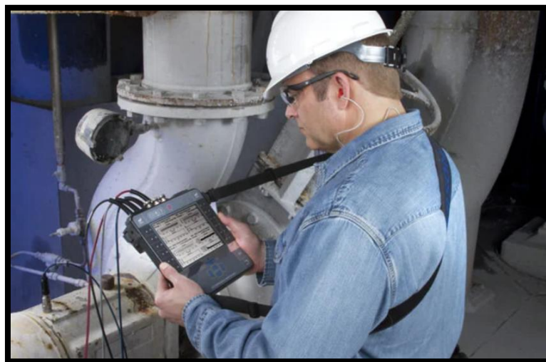
Figura 17 - Medição de vibrações. Fonte: novaspect.com
