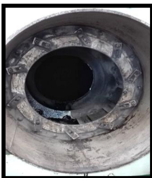
Figura 3.21 Abertura da caldeira nº 2 depois da limpeza
