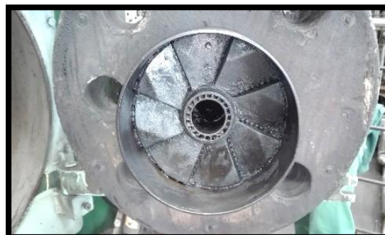
Figura 3.22 Porta da caldeira nº 2 depois da limpeza
