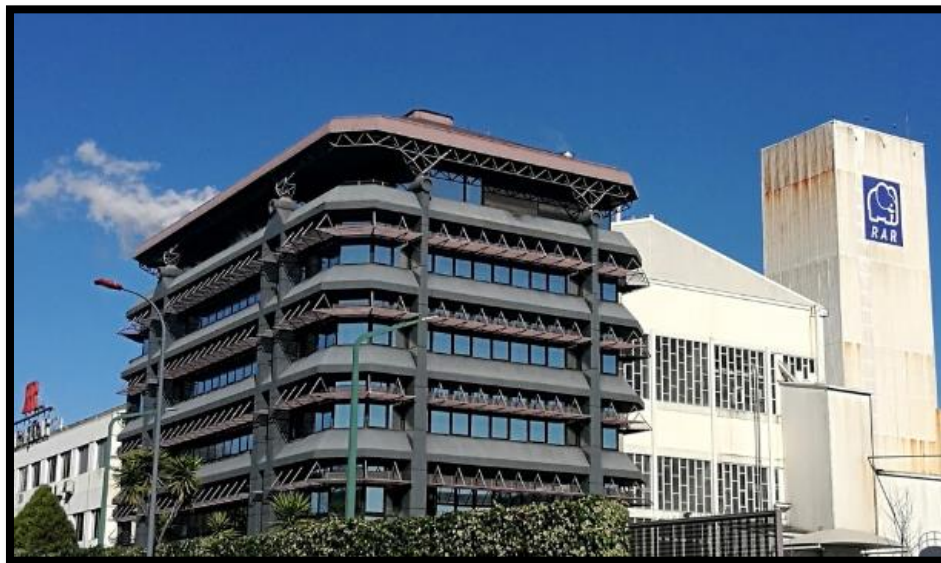
Figura 1.4 Edifício da RAR [8]
