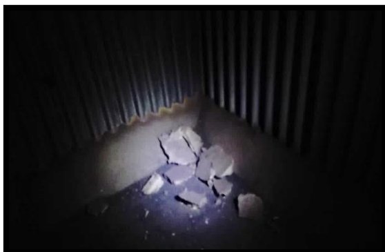
Figura 3.23 Interior da caldeira nº 2 antes da limpeza
