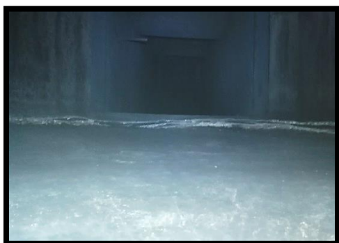
Figura 3.29 Chaminé das caldeiras 2 e 3 depois da limpeza (1)
