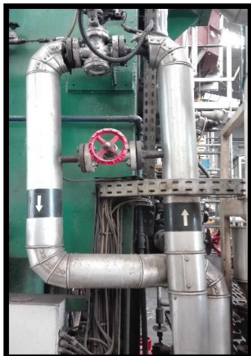
Figura 3.35 Tubagem antes da intervenção e da nova válvula de globo para o retorno do fuelóleo nº3 ao depósito
