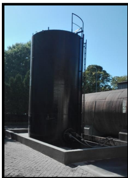
Figura 3.38 Bacia de retenção do reservatório novo
