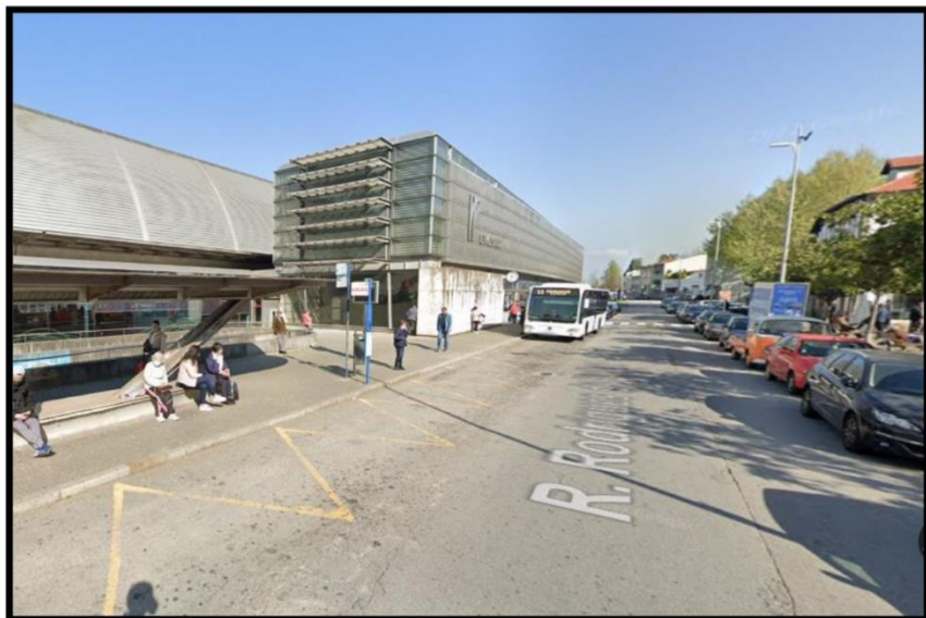
Anexo A9- Fotografia da atual Estação Ferroviária de Ermesinde.
