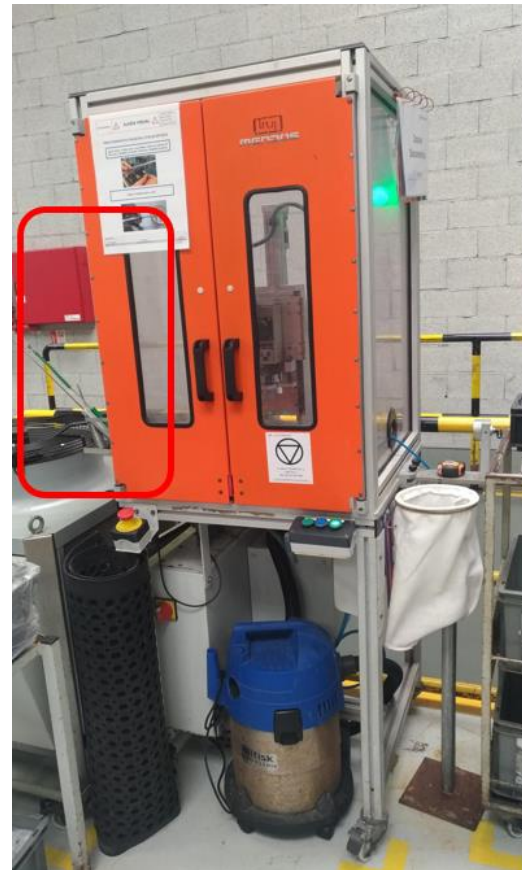
Figura 133 - Máquina de furar depois de montagem do suporte
