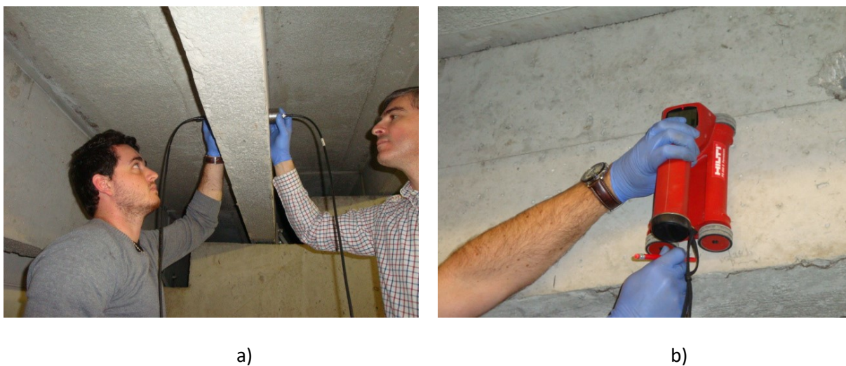
Figura 4.44 — Ensaio de ultra-sons do betão: a) posicionamento dos transdutores; b) identificação do posicionamento de armaduras.
