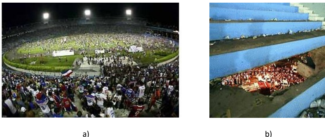
Figura 1.3 — Estádio Octávio Mangabeira (Bahiano, 2007): a) vista geral durante os festejos que antecederam o acidente; b) vista da bancada que colapsou.
