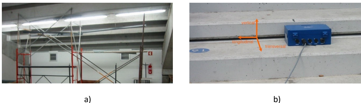
Figura 1.11 — Instrumentação dos degraus da bancada norte (Marques, 2009): a) Instalação de LVDT's sob os degraus da bancada norte; b) Instalação de sismógrafo sobre degraus de bancada norte.
