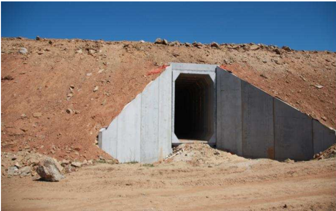
Figura 3.16: Box Culvert idêntica à monitorizada nesta aplicação prática (Cristelo, 2011).
