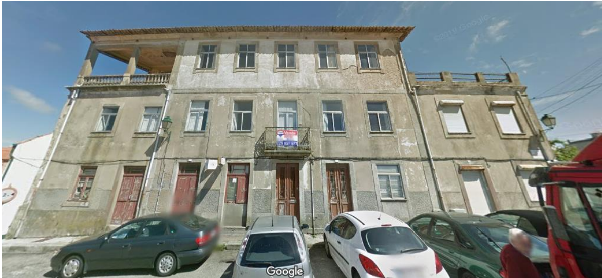
Figura 12 - Imagem do edifício em estudo, situado à Rua Gomes Fernandes nº88-100. (Fonte: [38])
