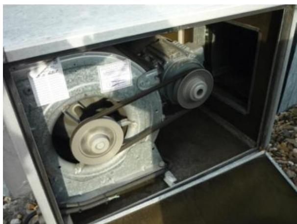
Figura H.22 - Ventilador
