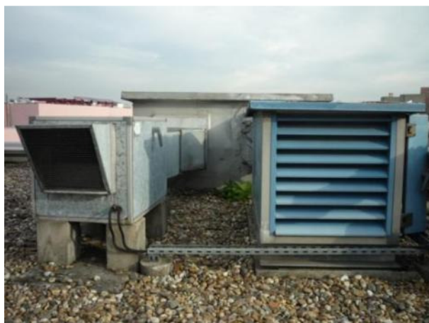
Figura H.23 - Aspecto geral
