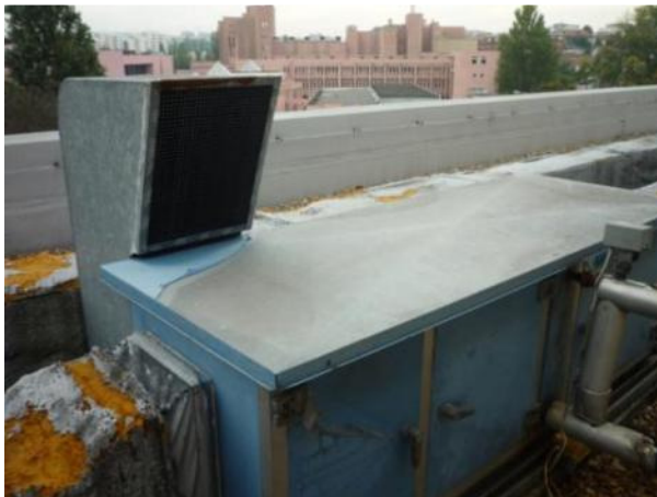
Figura H.9 – Captação de ar
