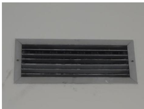
Figura H.41 - Grelha de Extração
