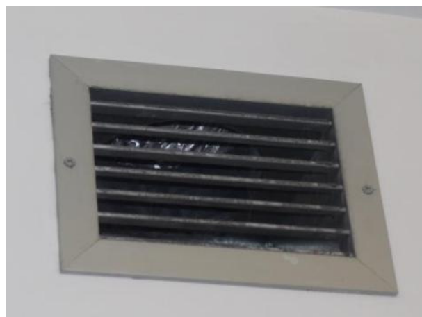
Figura H.46 - Grelha de Extração
