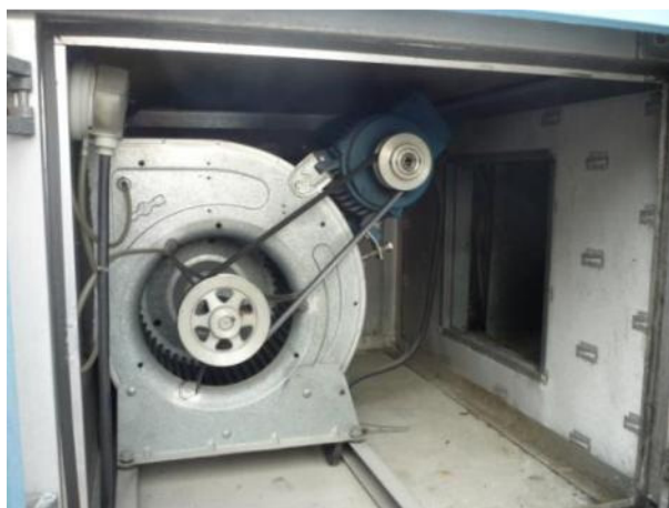
Figura H.15 - Ventilador
