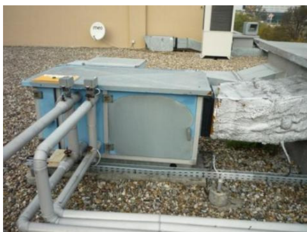
Figura H.24 - Acesso à UTA
