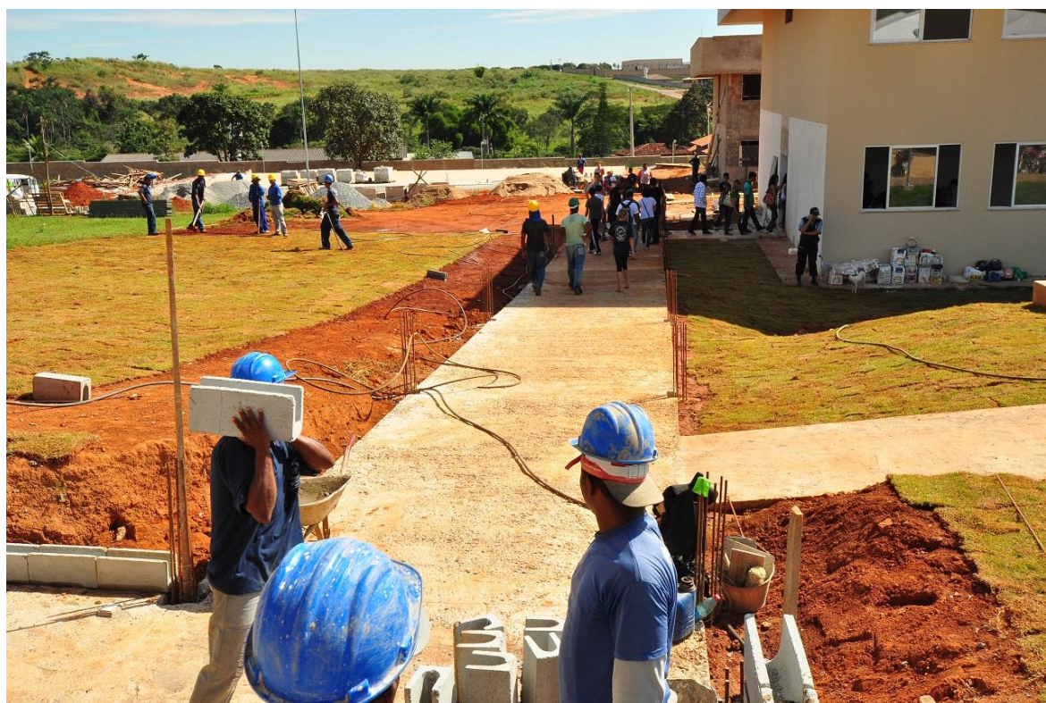
Figura 5 - Início das aulas em meio às obras no processo de implantação do Câmpus em 11/04/2013
