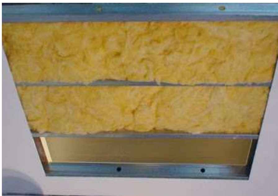
Figura 2.6 - Isolamento do teto com lã de vidro
