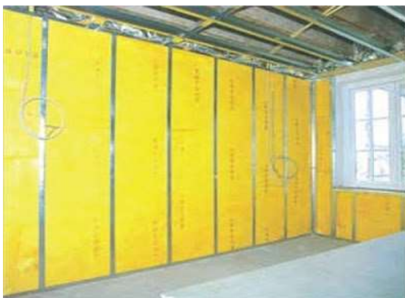
Figura 2.7 - Isolamento de paredes com lã de vidro.
