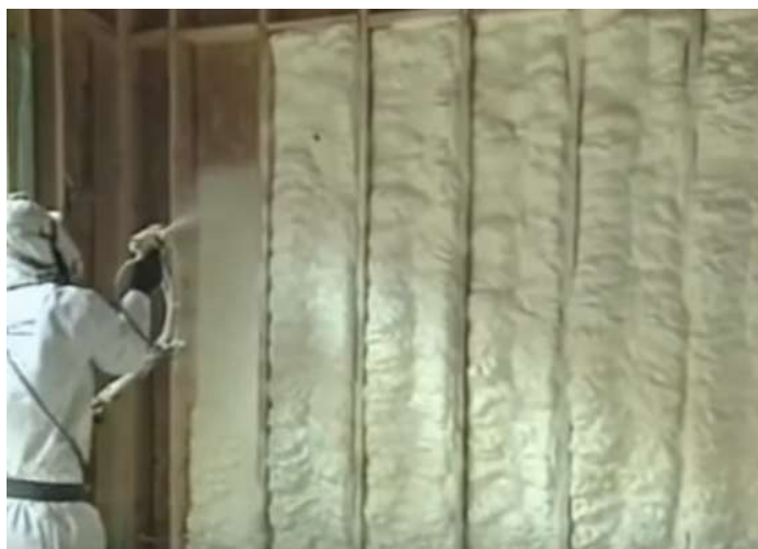
Figura 2.15 - Aplicação de espuma de poliuretano em spray, para isolamento térmico interno.
