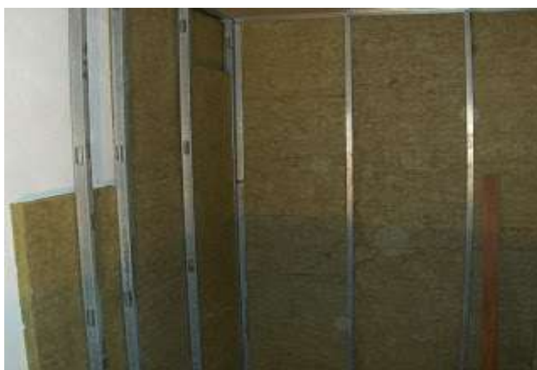
Figura 2.5 - Aplicação de lã de rocha entre divisórias.
